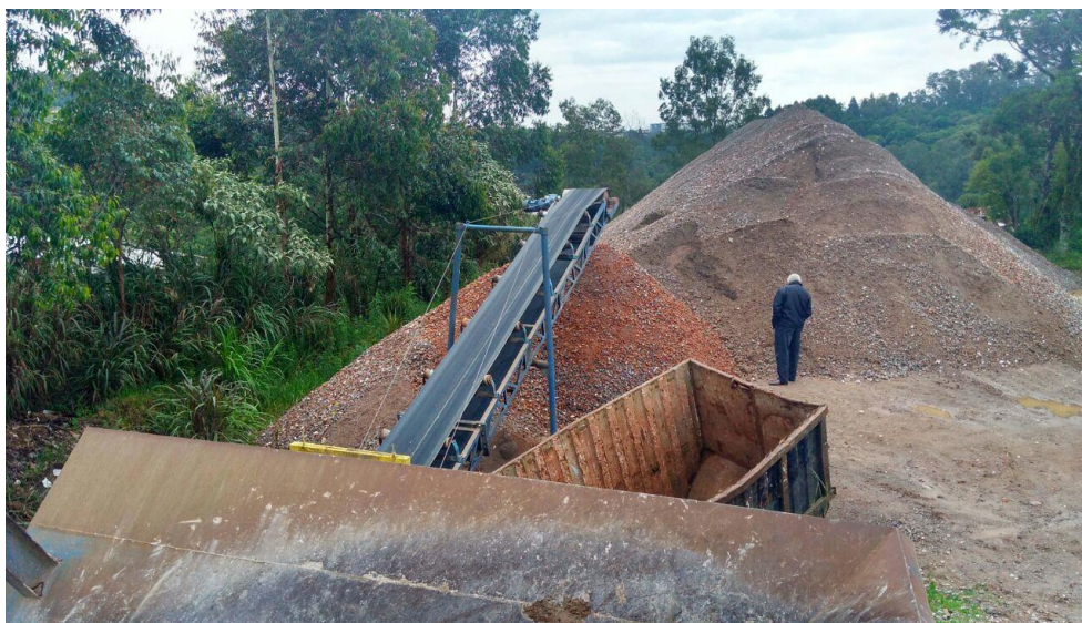
Figura 12: Esteira de transporte de RCC sem taliscamento.
