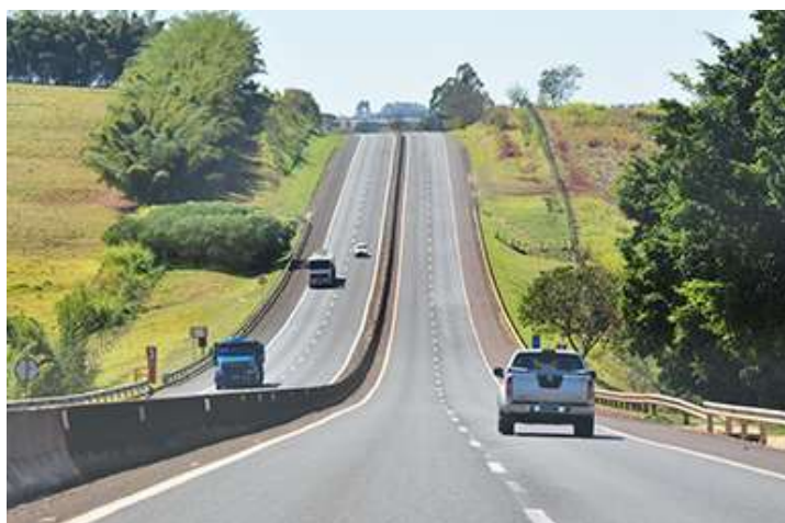
Figura 3: Rodovia duplicada com mureta central (Portal Estradas).
