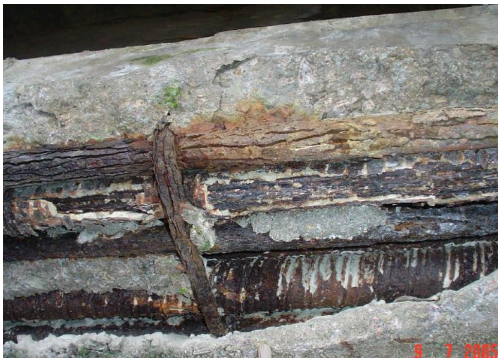
Foto 3 – Exposição da armadura, com cobrimento deficiente e diversos remendos aparentes no concreto.
