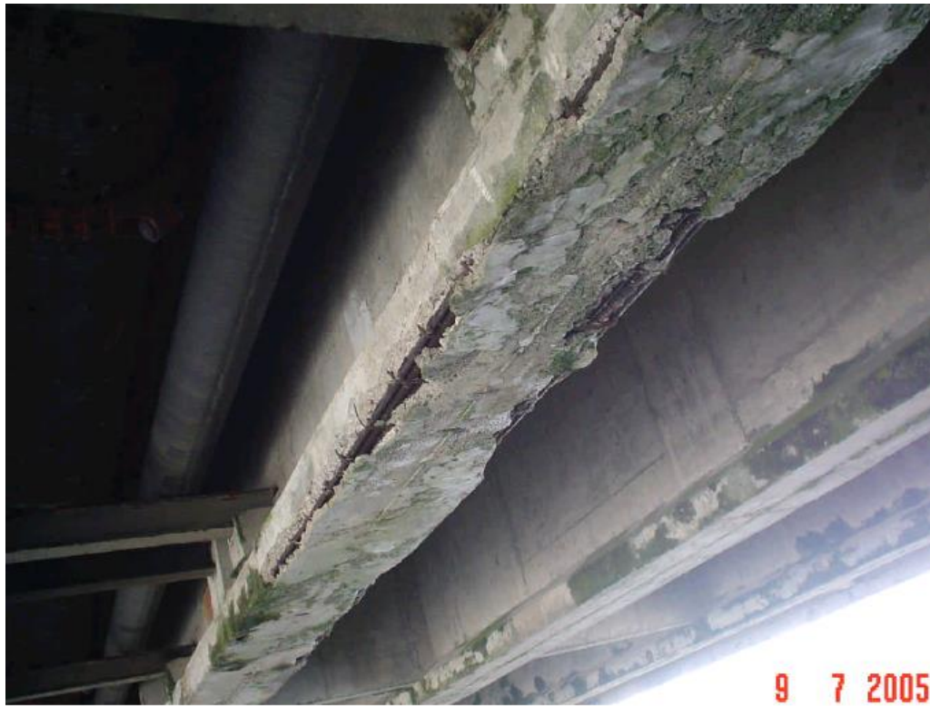
Foto 3 – Exposição da armadura, com cobrimento deficiente e diversos remendos aparentes no concreto.
