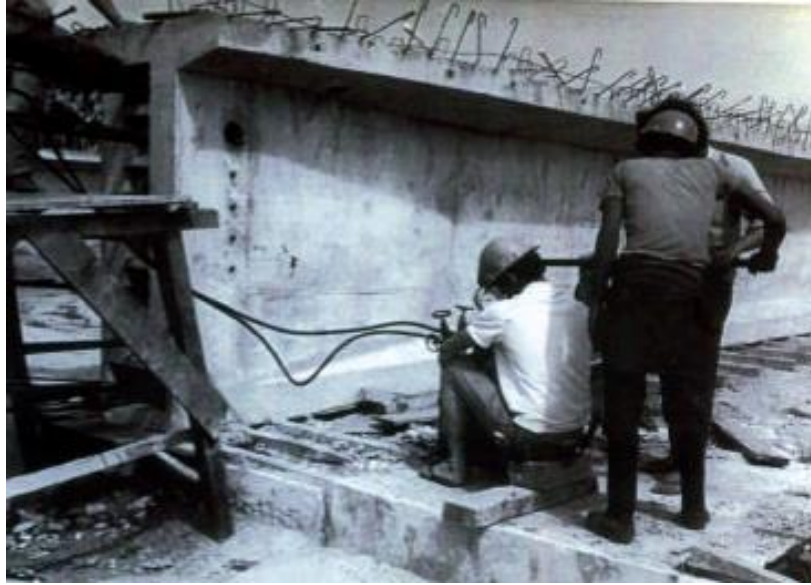
Foto 15- Trabalho de protensão das vigas no canteiro
