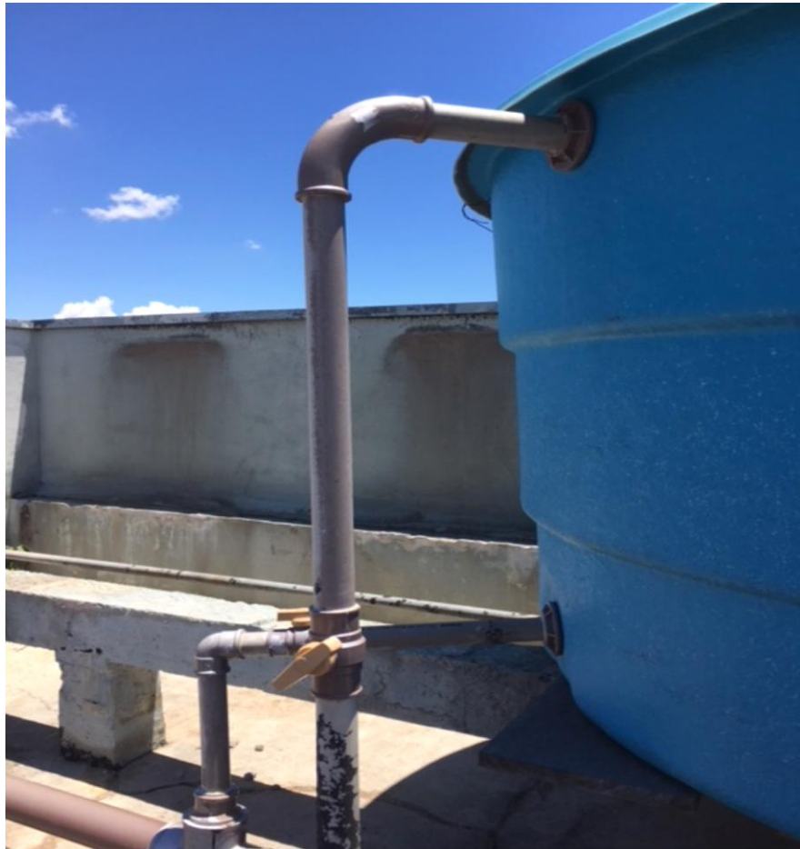
Figura 5 – Válvula parcialmente aberta
