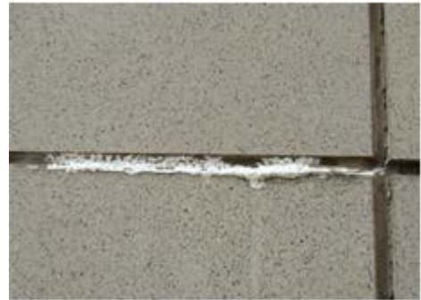
Figura 7 - Eflorescência em argamassas para rejuntamento
