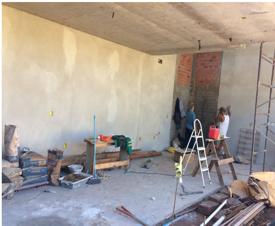
Figura 10 - Foto do Depósito e Sala Multiuso
