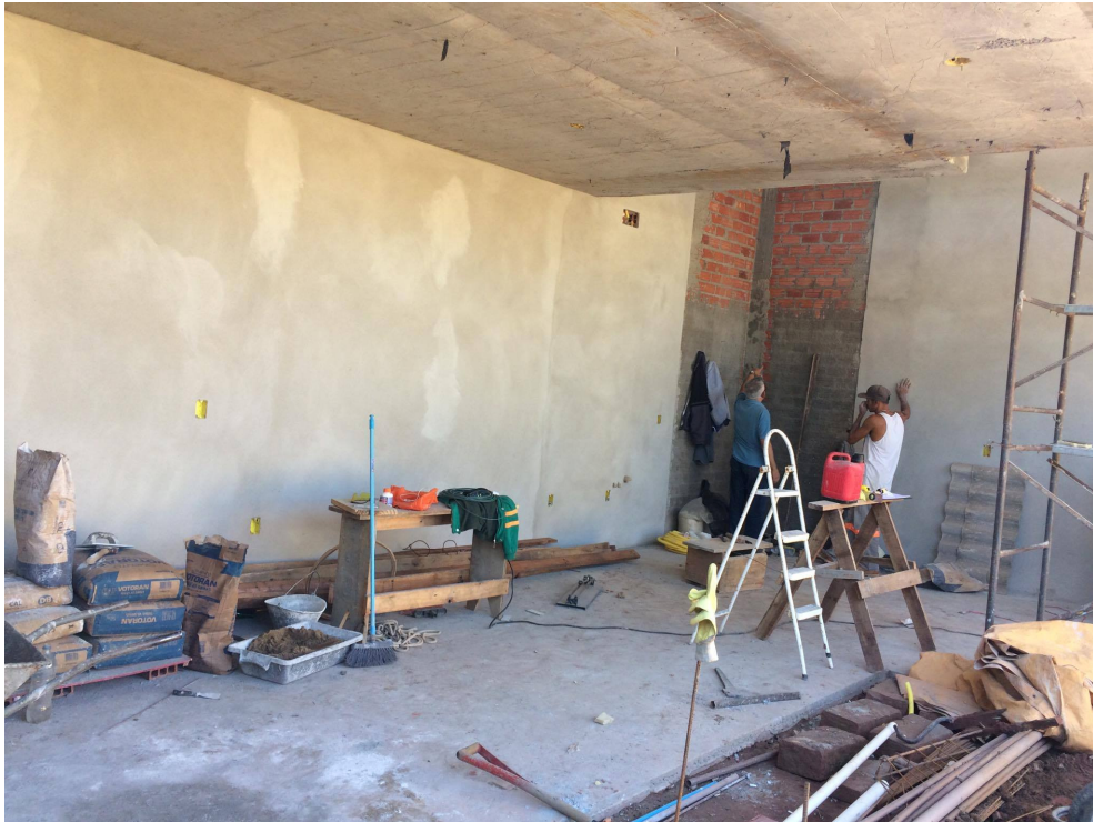
Figura 28 - Foto Interior Obra 3
