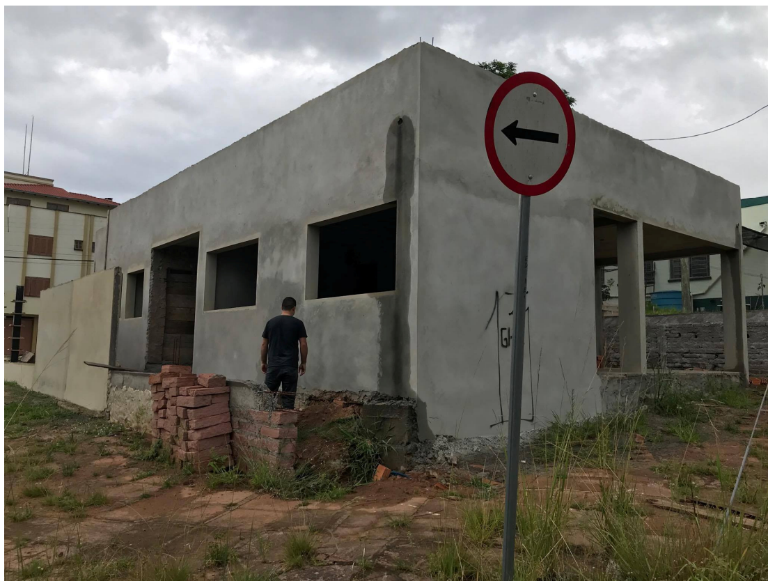
Figura 21 -Foto 2 da Obra 1
