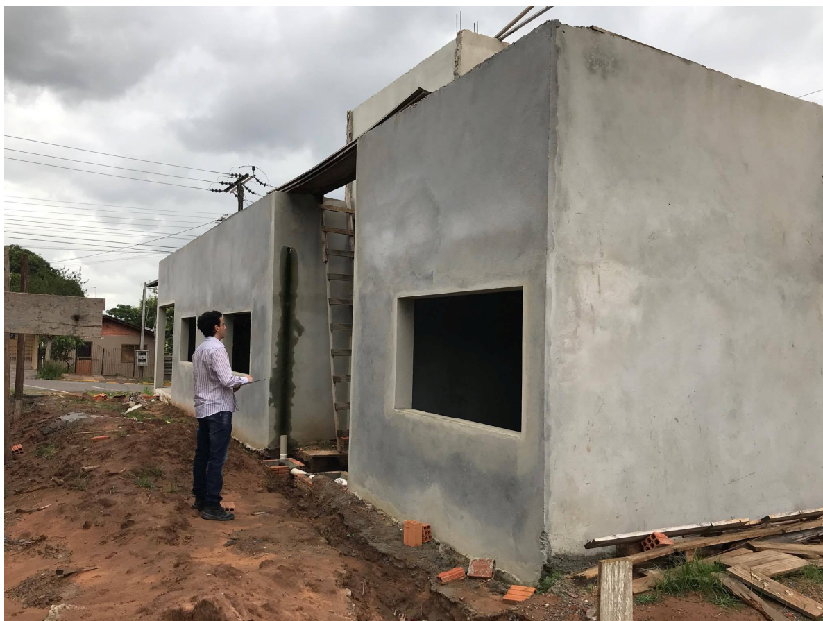
Figura 20 – Foto 1 da Obra 1
