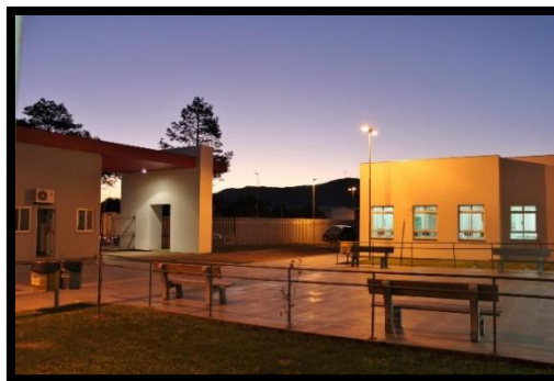
Figura 6.2: Pátio interno do IFRS Campus Osório.
