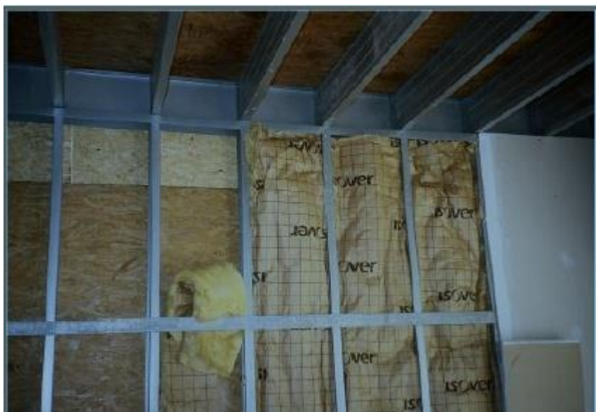
Figura 14 – Isolamento termoacústico com lã de vidro
