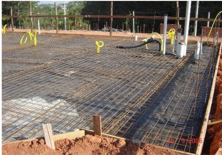
Figura 4 – Disposição da manta, armaduras e instalações
