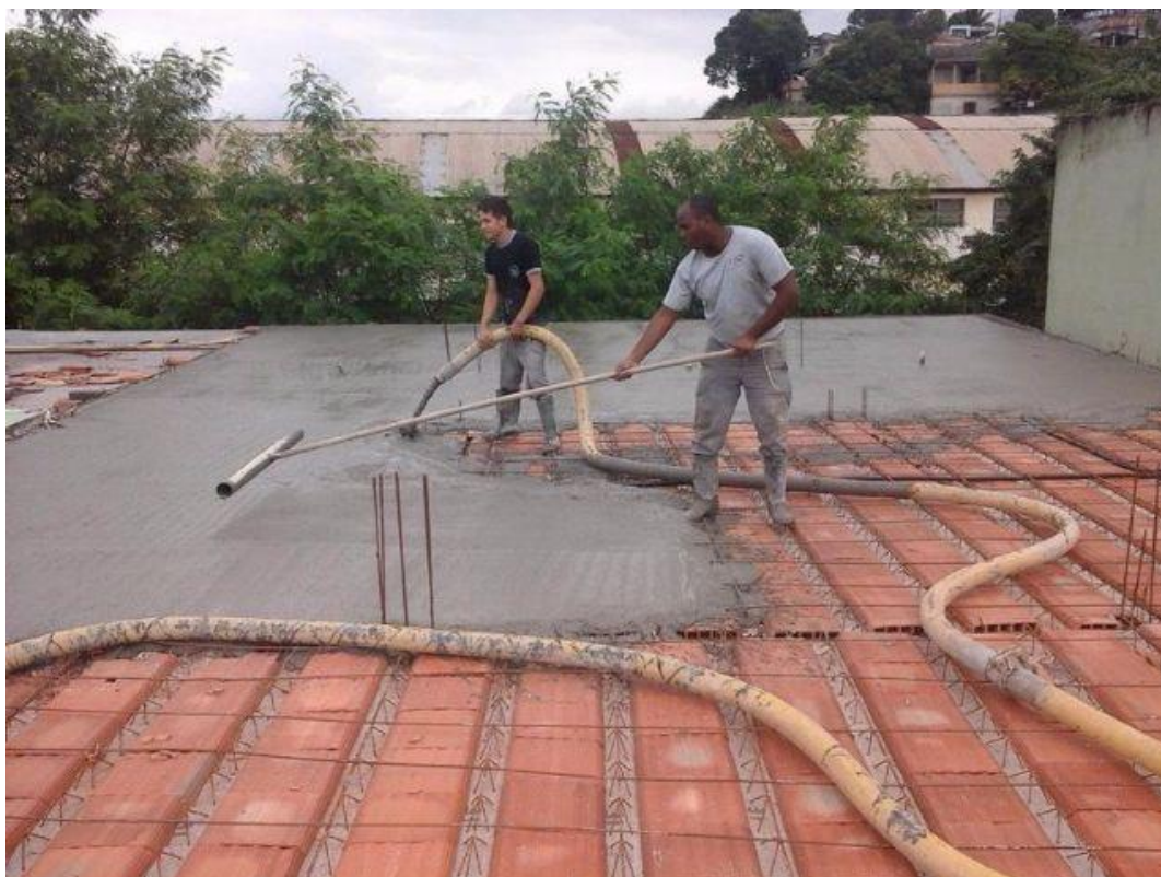
Figura 31 – Laje pré-fabricada
