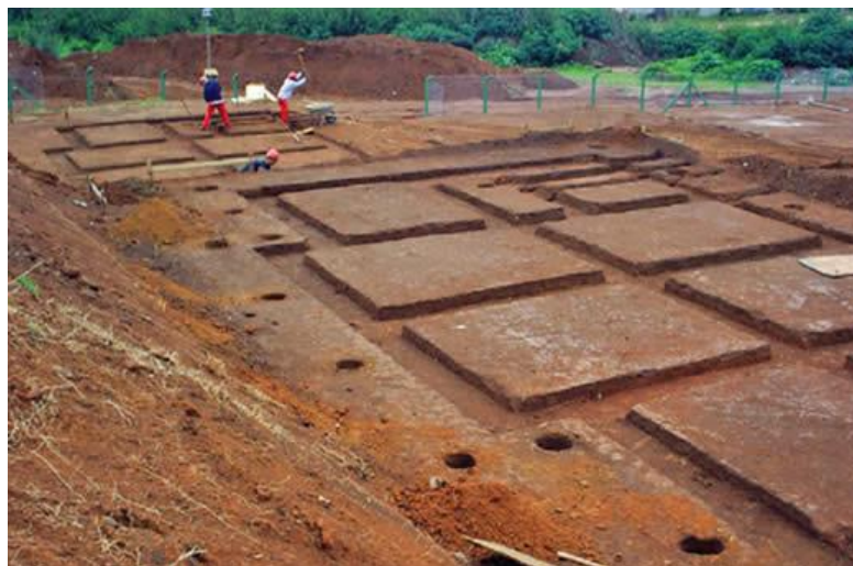
Figura 3 – Escavação para vigas baldrame
