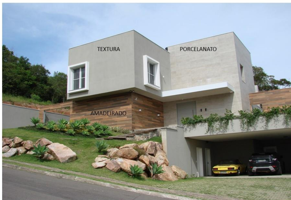
Figura 11 – Acabamentos externos (revestimento porcelanato amadeirado, porcelanato grandes formatos e textura)
