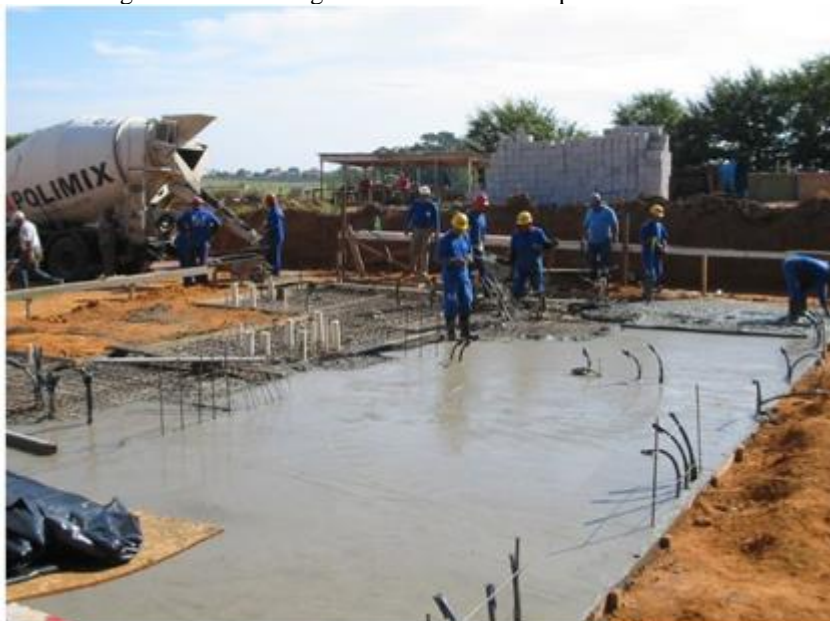
Figura 5 – Concretagem e alisamento da superfície do radier
