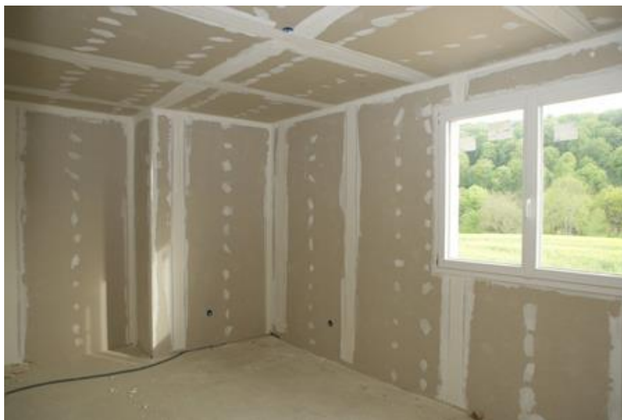
Figura 12 – Fechamento interno com placas de gesso acartonado
