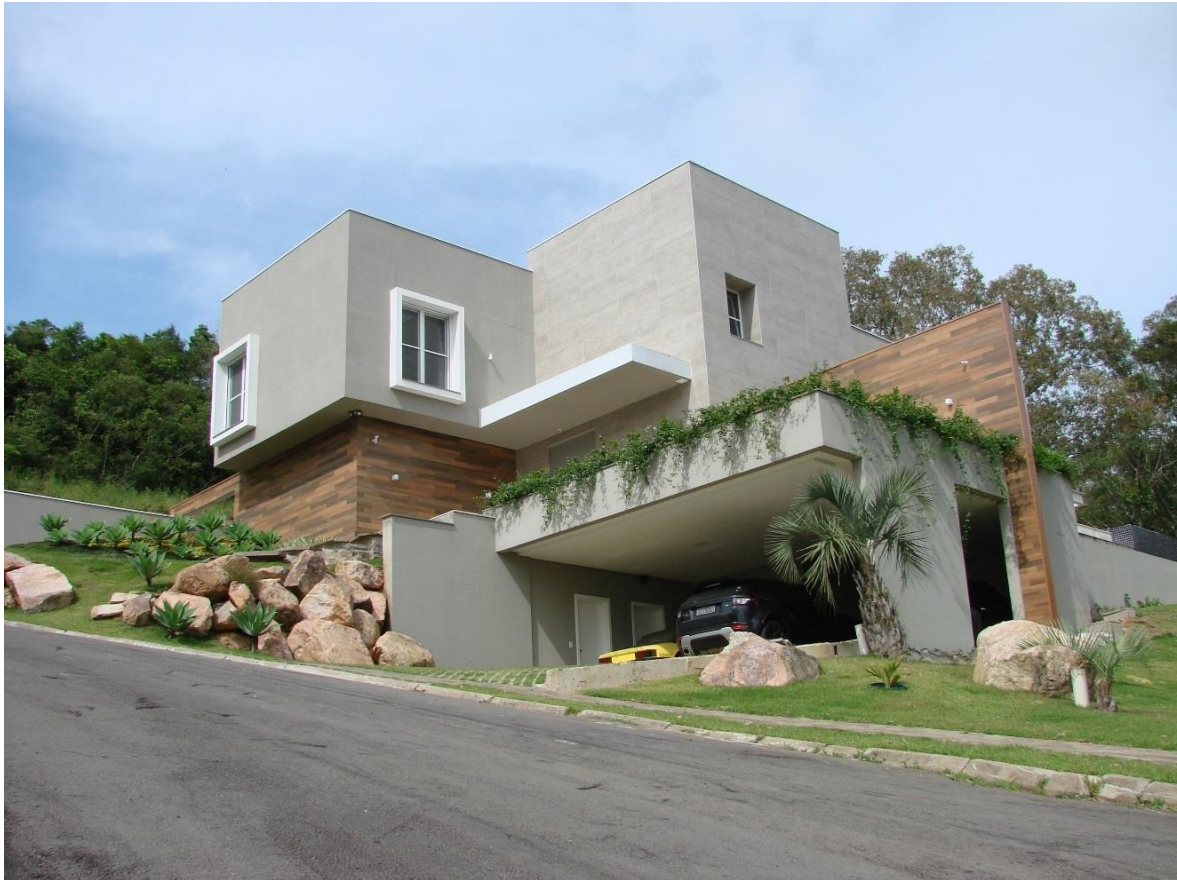
Figura 22 – Fachada lateral da residência
