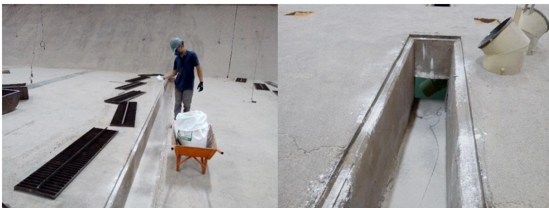
Figura 8 - Aplicação de terra de diatomácea nas canaletas de aeração nos armazéns da empresa. Rio verde (2018).
