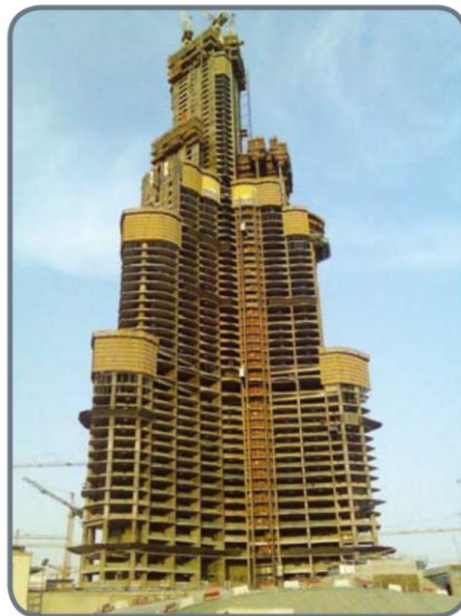
Figura 1.1 - Estrutura de concreto armado utilizada no arranha-céu Burj Khalifa (CONCRETO & CONSTRUÇÕES, 2009).
