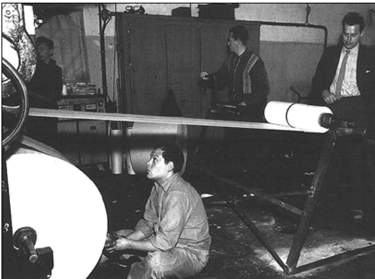
Fig.142. Manzoni durante a execução da obra Linha de 7200 metros 173 .
