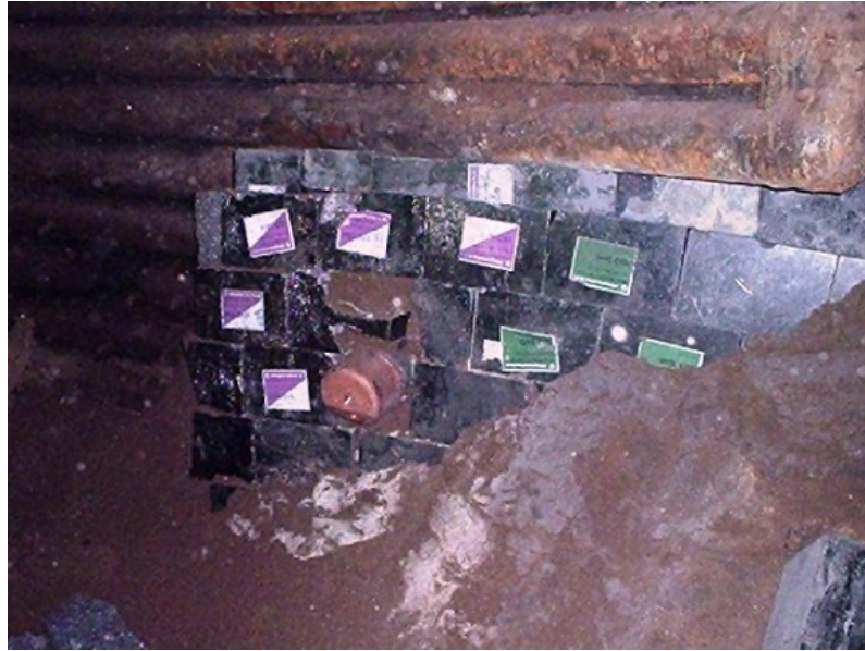
Figura 41 – Montagem da injetora MPDF no refratário antes de partir o forno.
