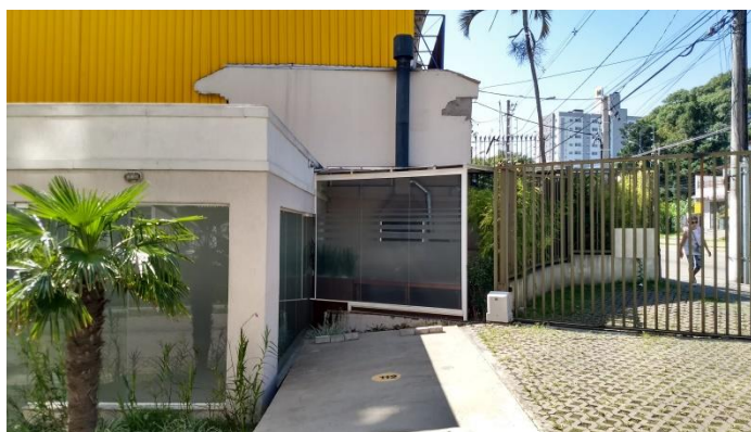
Figura 11 – Ampliação do salão de festas
