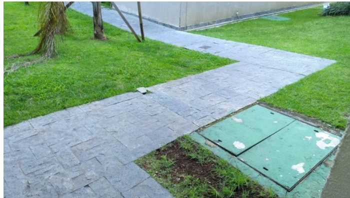
Figura 17 – Registro feito in loco do acesso ao bloco B
