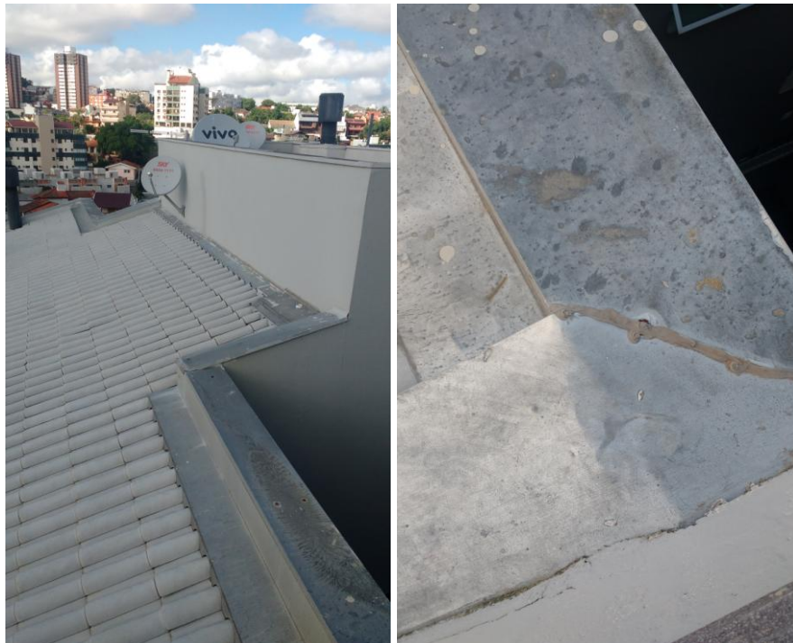
Figura 29 – a) Elementos de vedação; b) Vedação entre módulos com PU
