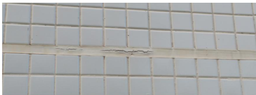
Figura 34 – Fina camada de selante rompido
