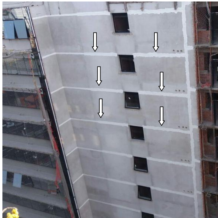
Figura 42 – Juntas de movimentação com membrana impermeabilizante
