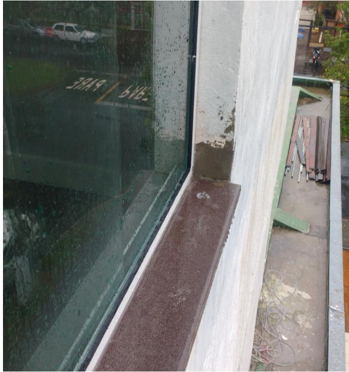
Figura 58 – Peitoril com pouco prolongamento da pingadeira e comprimento igual ao vão
