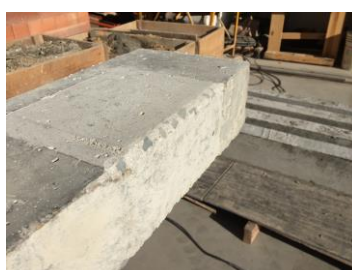
Figura 19b – Superfície pronta para recebimento do reforço
