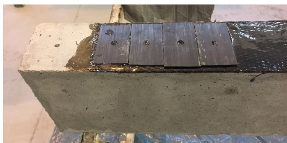
Figura 22a – Placas de laminado posicionadas sobre a viga.
