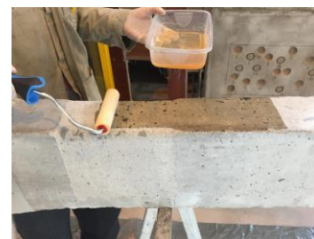
Figura 19c – Aplicação do primer
