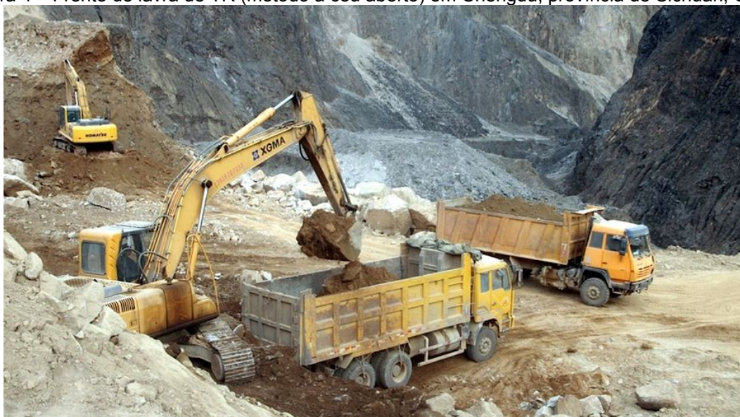
Figura 4 – Frente de lavra de TR (método a céu aberto) em Chengdu, província de Sichuan, China.
