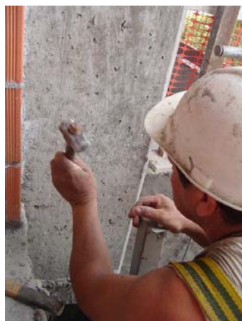
Figura 3.4 – Apicoamento manual realizado em obra em Porto Alegre
