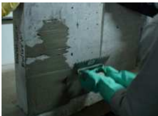
Figura 5.35 – Imprimação do substrato com o chapisco industrializado
