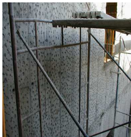
Figura 3.5 – Superfície parcialmente apicoada (MENDEZ et al., 2003)
