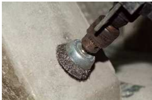
Figura 3.2 – escovação mecânica (JÚLIO, 2004)
