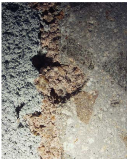
Figura 6.84 – Interface concreto 35 MPa apicoado, chapisco convencional, ampliação de 7,6x
