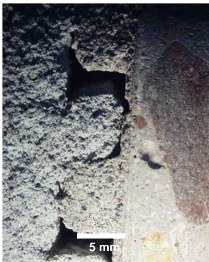
Figura 6.76 – Interface concreto 45 MPa com desmoldante lav quente, ch ind, Estudo Preliminar – ampliação 6,7x
