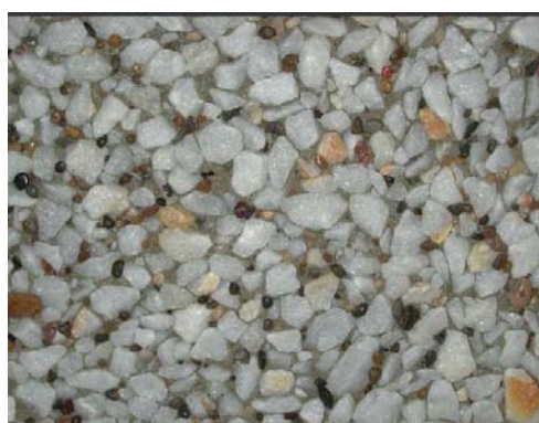
Figura 3.17 – Superfície com agregado exposto pelo uso de retardador de pega de superfície (CABREDO et al, 2003)
