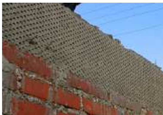
Figura 3.16 – Superfície após a desfôrma (MENDEZ et al., 2003)
