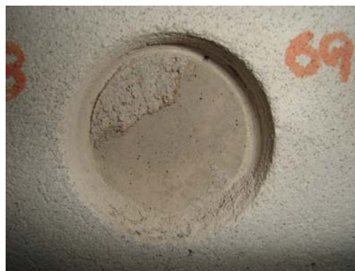
Figura 5.40 – Detalhe de ruptura em corpo-de-prova
