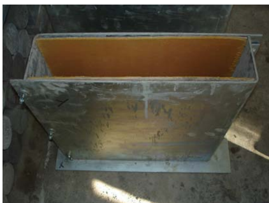
Figura 5.18 – Instalação das lâminas de madeira na fôrma metálica
