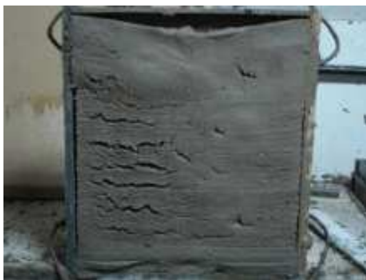
Figura 5.14 – Fissuras ainda no estado fresco
