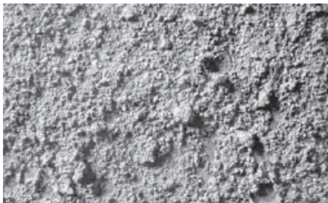
Figura 3.19 – chapisco convencional (CEOTTO et al., 2005)
