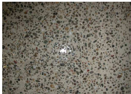
Figura 3.9 – Superfície totalmente apicoada (CABREDO et al., 2003)
