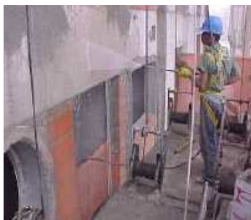
Figura 3.12 – Lavagem por hidro-jateamento (GARCIA, 2006)
