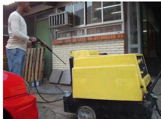
Figura 5.5 – Execução da lavagem a quente
