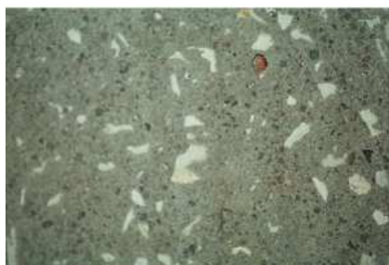
Figura 3.11 – Superfície após tratamento com jato de areia (JÚLIO, 2004)
