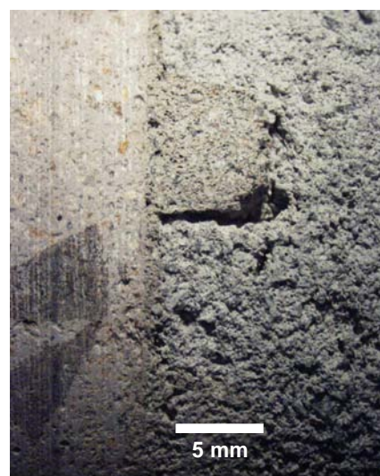
Figura 6.75 – Interface concreto 25 MPa – sem desmoldante lavado, ch ind, Estudo Preliminar, ampliação 6,7x
