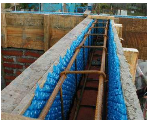
Figura 3.15 – Fôrma com o plástico pronta para o lançamento do concreto (MENDEZ et al., 2003)
