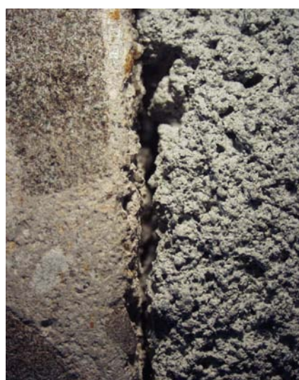
Figura 6.87 – Interface concreto 25, retardador de pega de superfície, sem chapisco, ampliação 6,7x.
