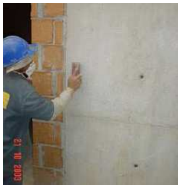
Figura 3.1 - Escovação Manual (Comunidade da Construção, 2005)
