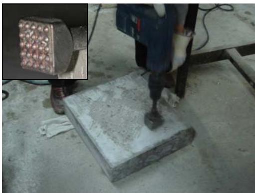
Figura 5.12 – Execução do apicoamento com o martetele eletromecânico
