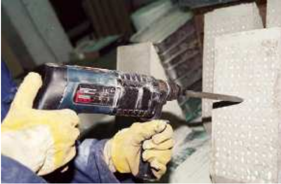
Figura 3.6 – Apicoamento parcial mecanizado. (JÚLIO, 2004)
