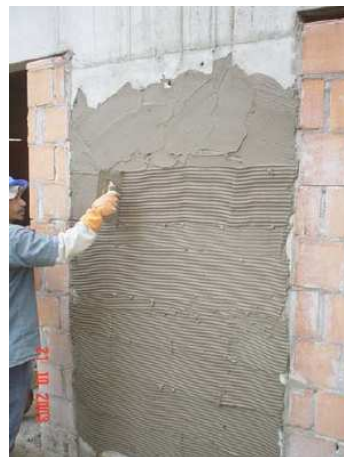
Figura 3.22 – chapisco industrializado. (Comunidade da Construção, 2005)
