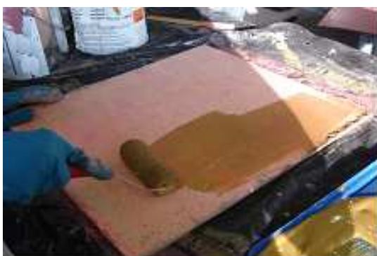
Figura 5.16 – Aplicação da primeira demão do retardador de pega de superfície
