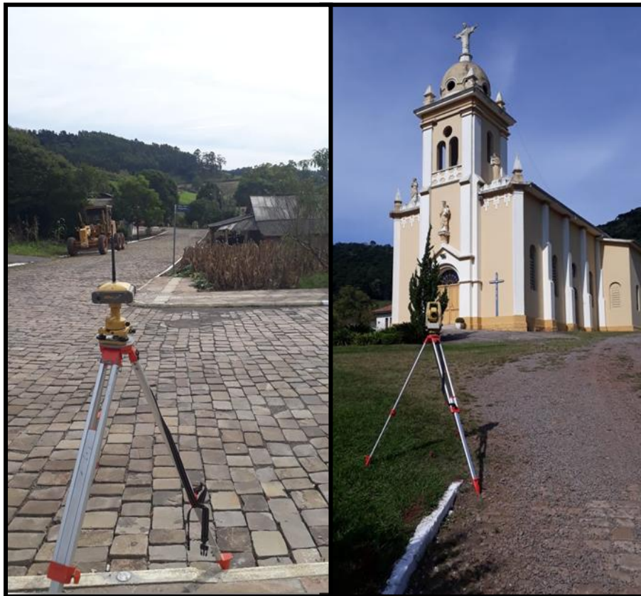
Figura 17 - Rastreamento através de GNSS e levantamento Topográfico através de Estação Total.
