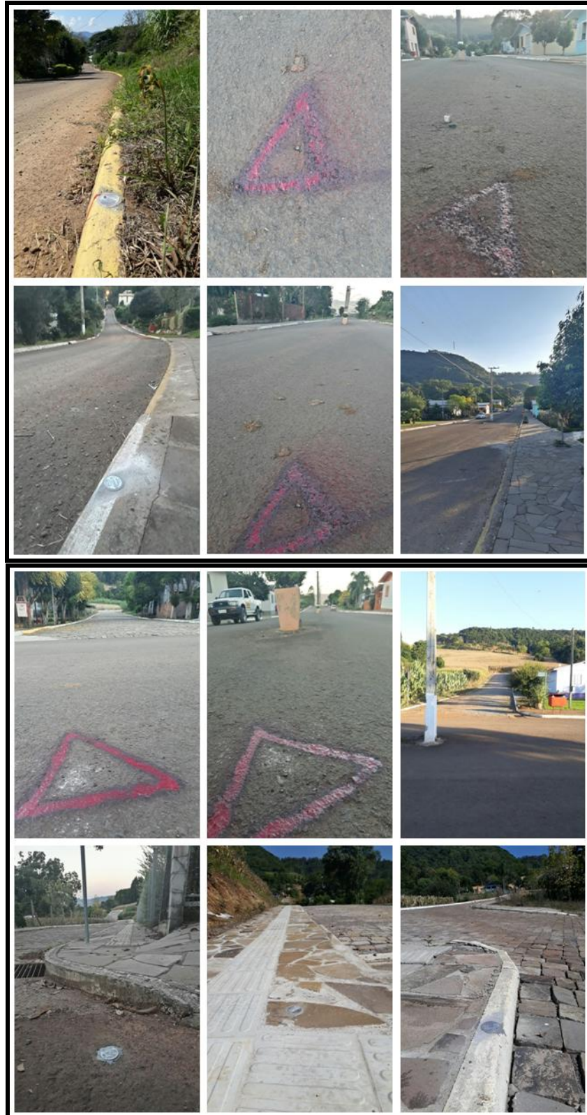
Figura 18 – Fotos da materialização das chapinhas e pregos da Rede Geodésica de Apoio Imediato.
