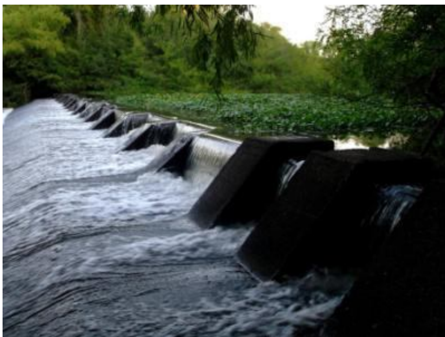
Figura 29- Barragem para a captação da água bruta para abastecimento público (Autora, 2014)
