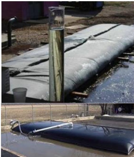
Figura 19- Bag (geotubo) confeccionado com manta geotêxtil (Fontes: SNATURAL, 2016)
