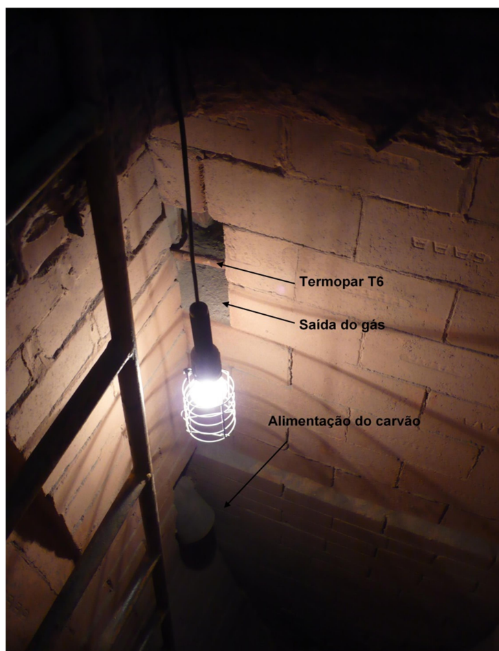
Figura C9 - Saída do gás dentro do reator.
