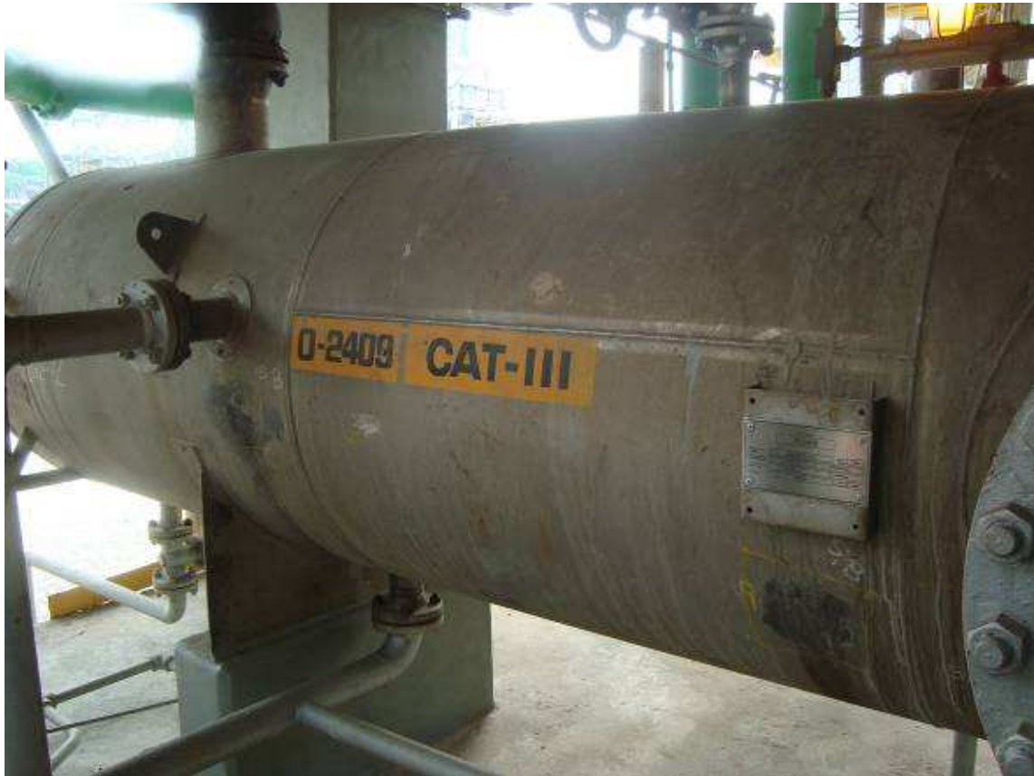
Fig. 6. Vaso de topo da torre regeneradora (vaso de refluxo.)
