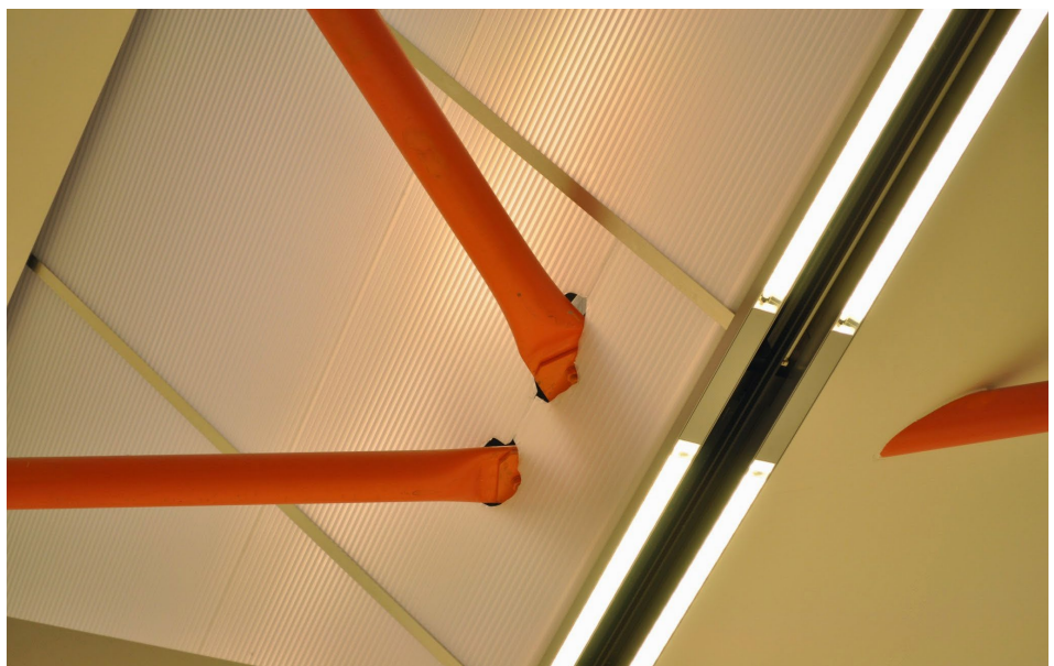
Fig. 6.48 - Kunsthal, OMA, 1987. “Detalhe” do encontro da estrutura metálica e forro de policarbonato.
