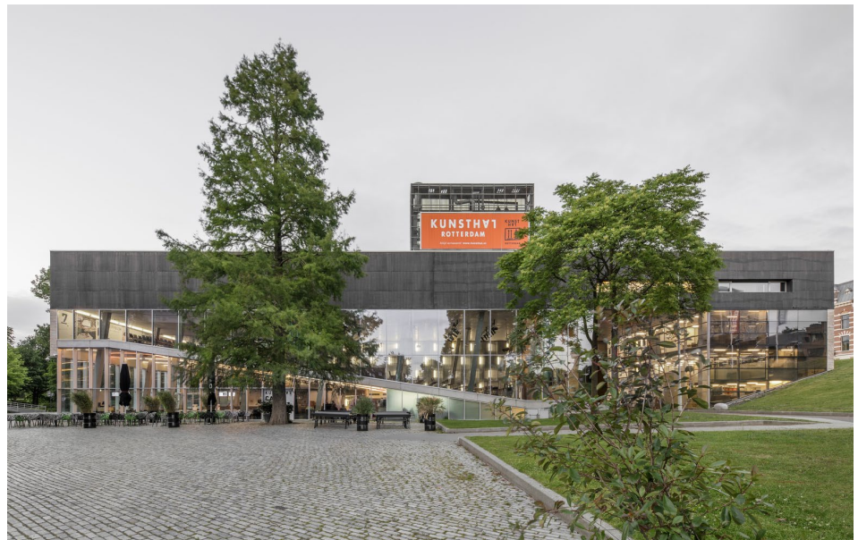
Fig. 6.41 - Kunsthal, OMA, 1987. Fachada oeste após reforma em 2014.
