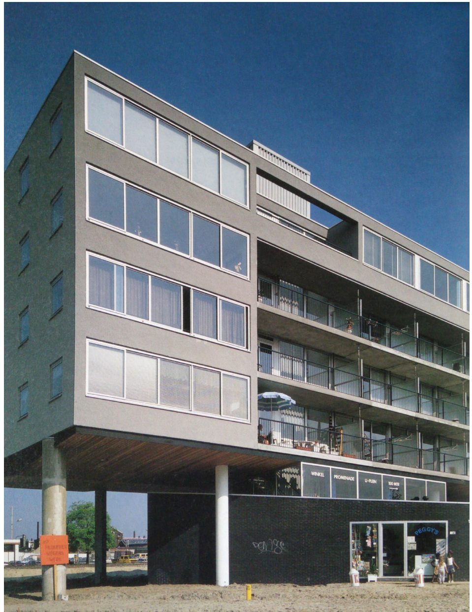
Fig. 4.32 - IJ Plein, OMA, 1981. Vista frontal do edifício mais alto do conjunto.
