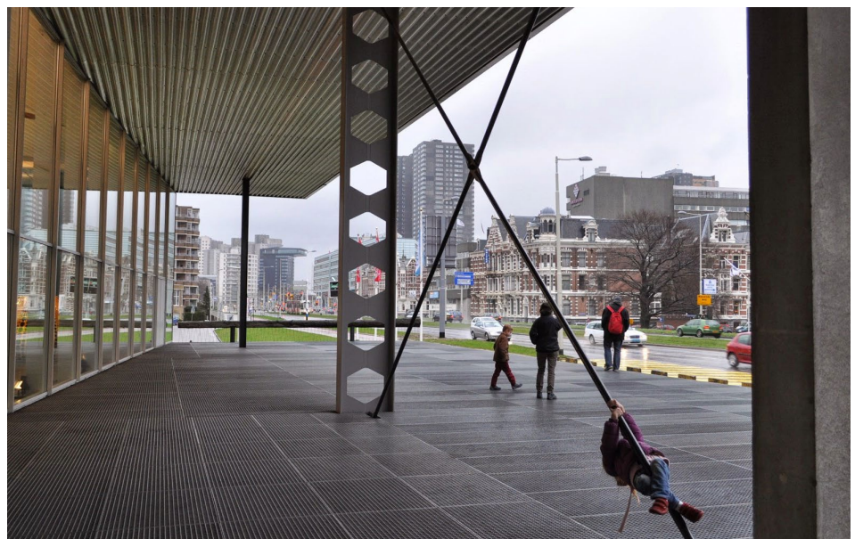
Fig. 6.42 - Kunsthal, OMA, 1987. Pilares heterogêneos na fachada sul.
