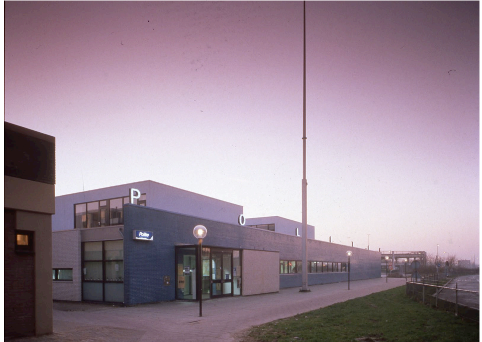
Fig. 3.11 - Estação de Polícia, OMA, 1982. Acesso principal.
