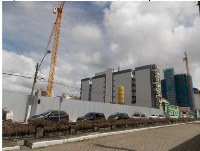
Figura 112. Construção do Studio Residence Plus II, a uma quadra do Studio Residence Plus.
