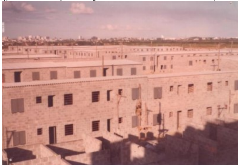
Figura 18. Construção do conjunto habitacional Cohab Guabirora, em 1983
