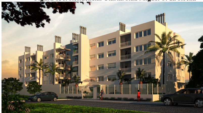
Figura 136. Residencial Olaria. Rua Miguel T. da Rocha
