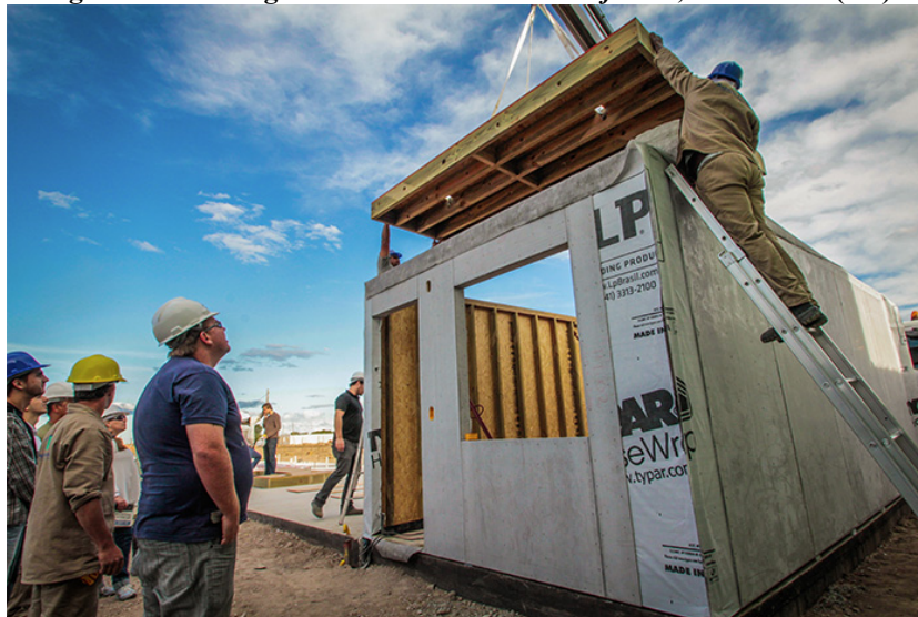
Figura 43. Montagem dos sobrados em woodframe , em Pelotas (RS)
