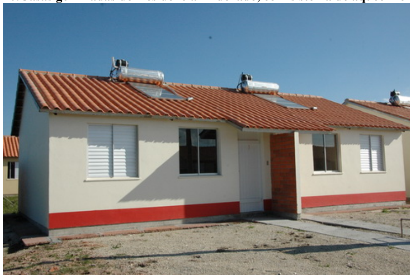
Figura 40. Casas geminadas do Residencial Eldorado, com sistema de aquecimento solar
