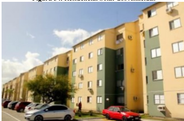
Figura 54. Residencial Solar dos Almeidas
