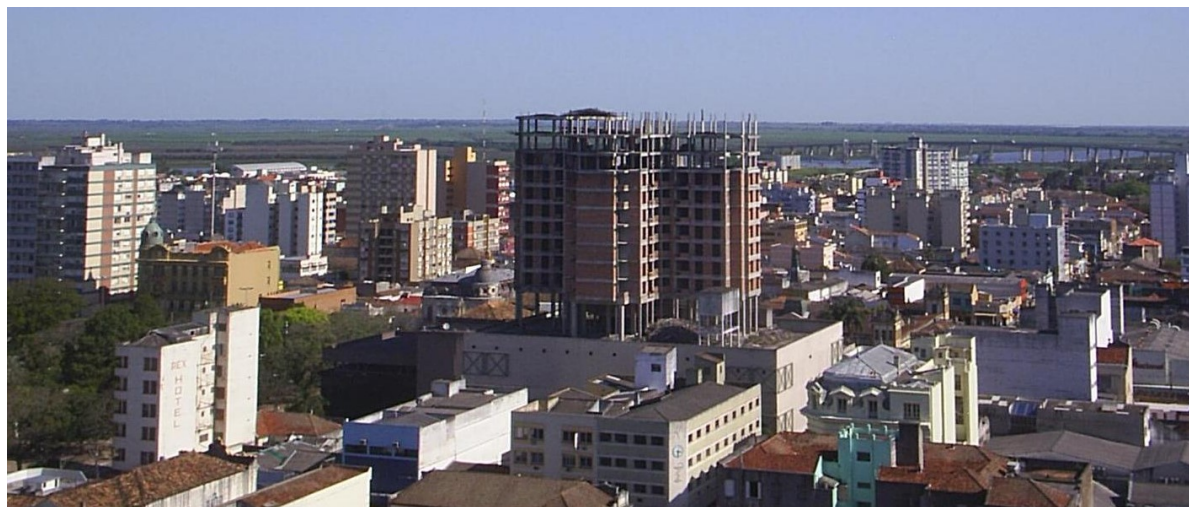
Figura 27. Torre inacabada do edifício Praça XV
