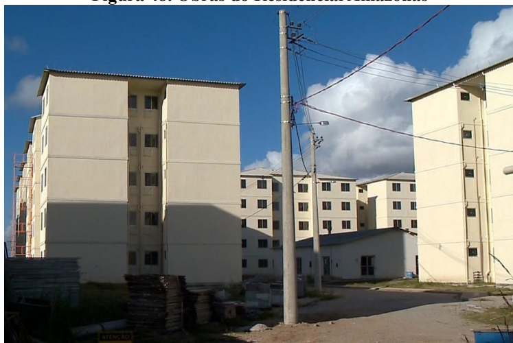
Figura 48. Obras do Residencial Amazonas
