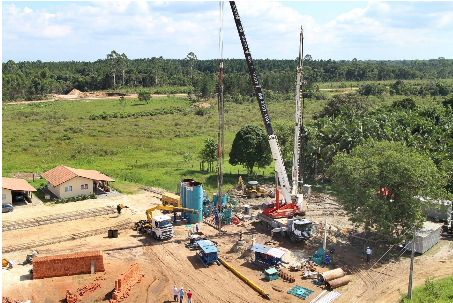
Figura 4-18 – Etapa de içamento da armadura: (a) definição dos pontos de apoio, (b) e (c) içamento da armadura e (d) vista aérea durante essa etapa
