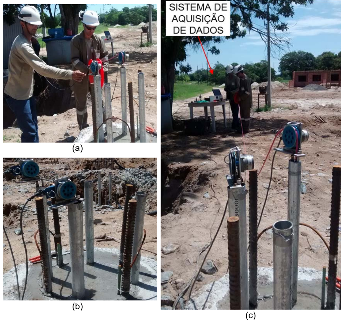
Figura 4-22 – Execução ensaio cross-hole : (a) inserção do transmissor e do receptor, (b) detalhe desses equipamentos já instalados e (c) conexão dos equipamentos ao sistema de leituras
