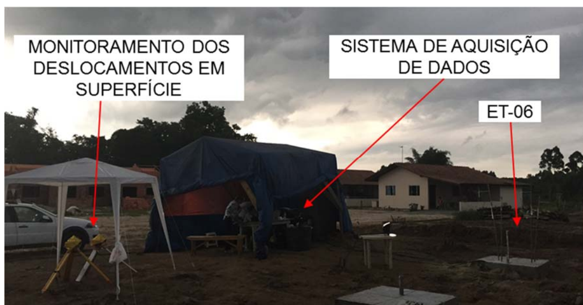
Figura 4-45 – Estrutura necessária para realização do ensaio bidirecional
