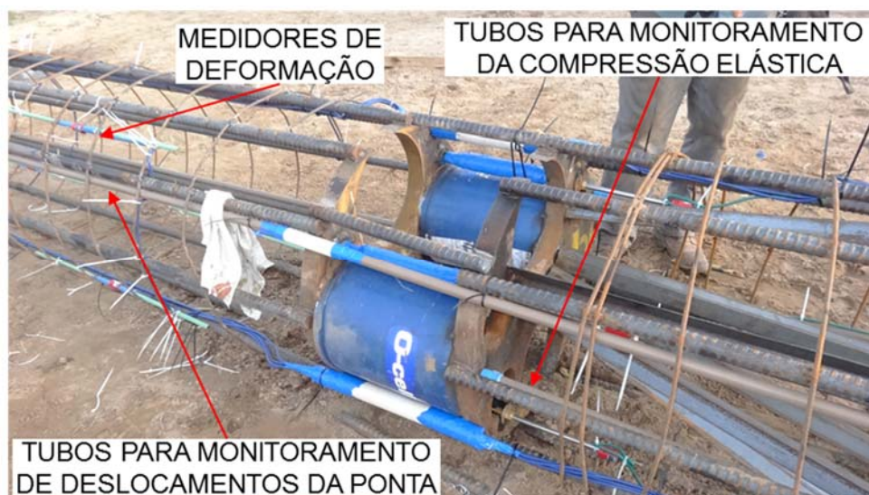
Figura 4-41 – Ensaio bidirecional: instrumentação para monitoramento do deslocamento de ponta, compressão elástica da parte superior da estaca e deformações ao longo do fuste
