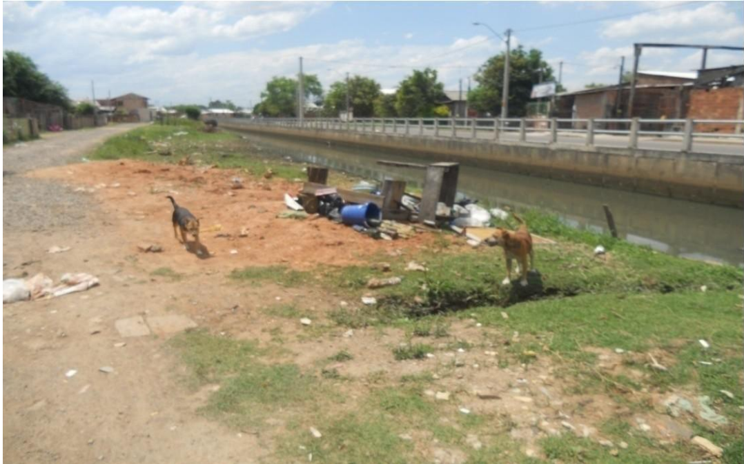
Figura 3: Imagem de "valão" não canalizado
