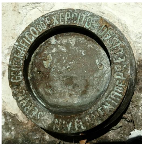
Figura 15 - RN implantada pelo Exército Fonte: O Autor.
