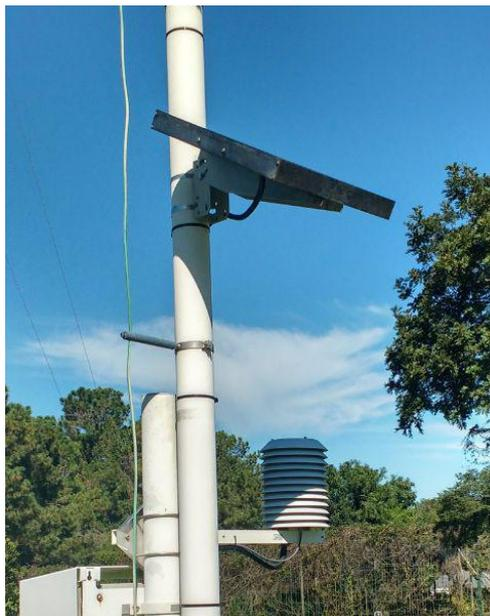
Figura 4.21: Abrigo meteorológico do INMET, da estação A801, sob a sombra da própria placa solar.
