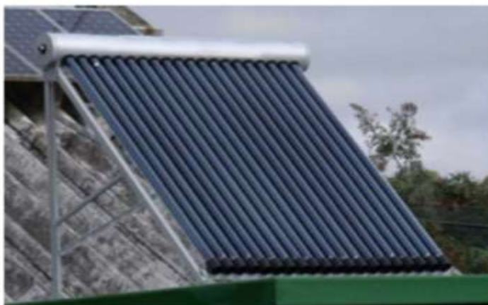
Figura 4. Coletor solar de tubo à vácuo.
