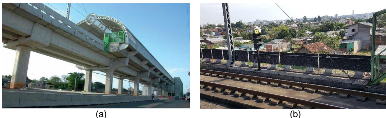
Figura 5.3: Vista externa da estação Santo Afonso (a) e muretas com isolamento acústico (b).
