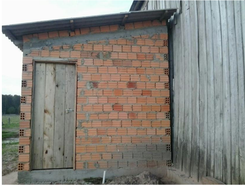
Figura 14: Local de armazenamento de herbicidas, inseticidas e fungicidas.
