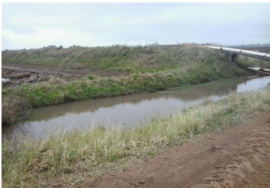
Figura 15: Reservatório e canal de rebombeamento da água.
