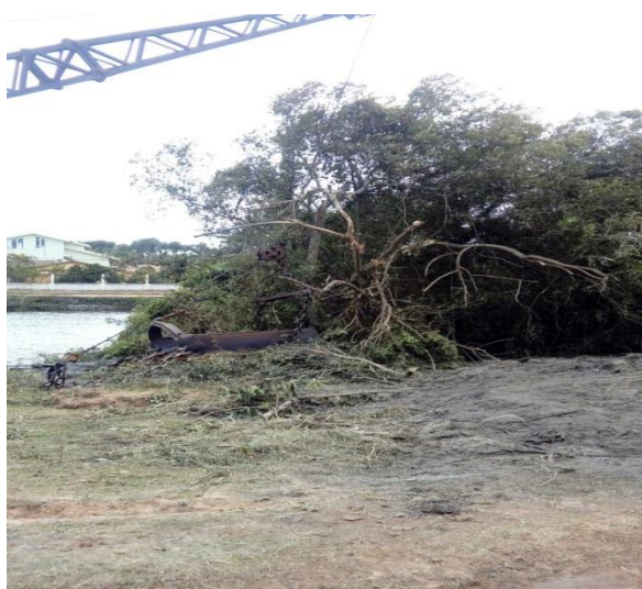
Figura 7: colocação de entulho junto à margem do Arroio São Lourenço
