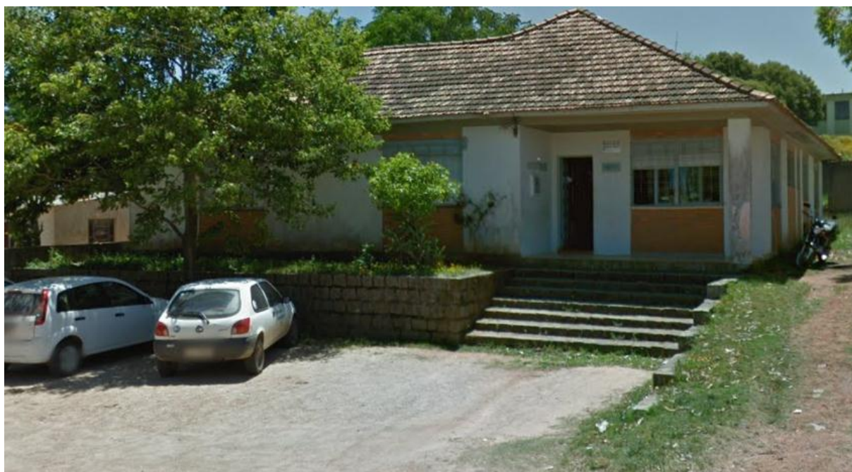
Figura 9 - Fachada prédio da EMATER em São Lourenço do Sul
