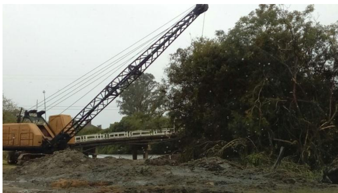
Figura 8: colocação de entulho junto à margem do Arroio São Lourenço
