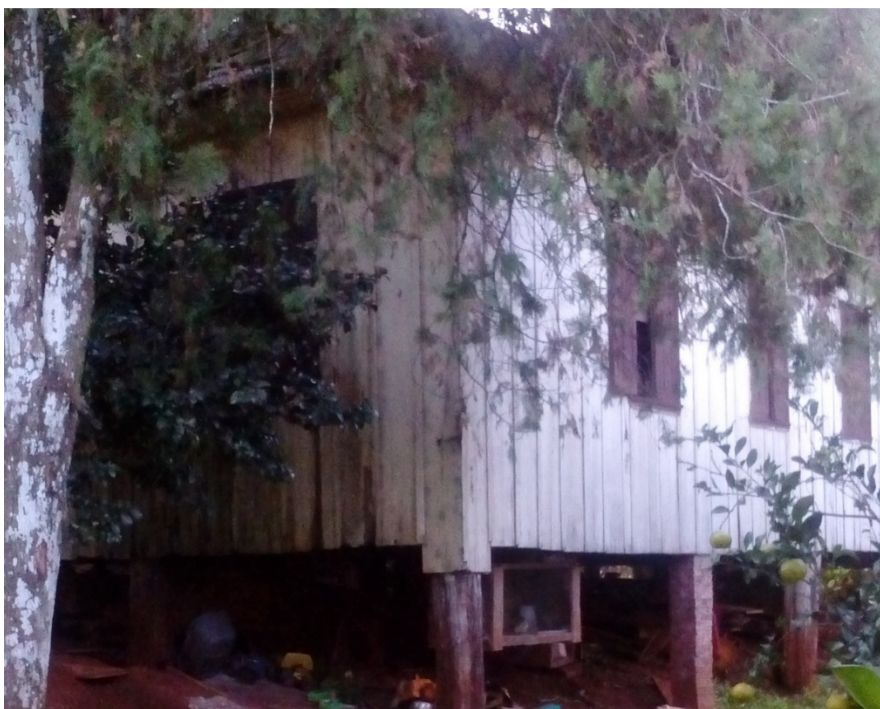
Figura 6 – Casa antiga da propriedade, utilizada como depósito
