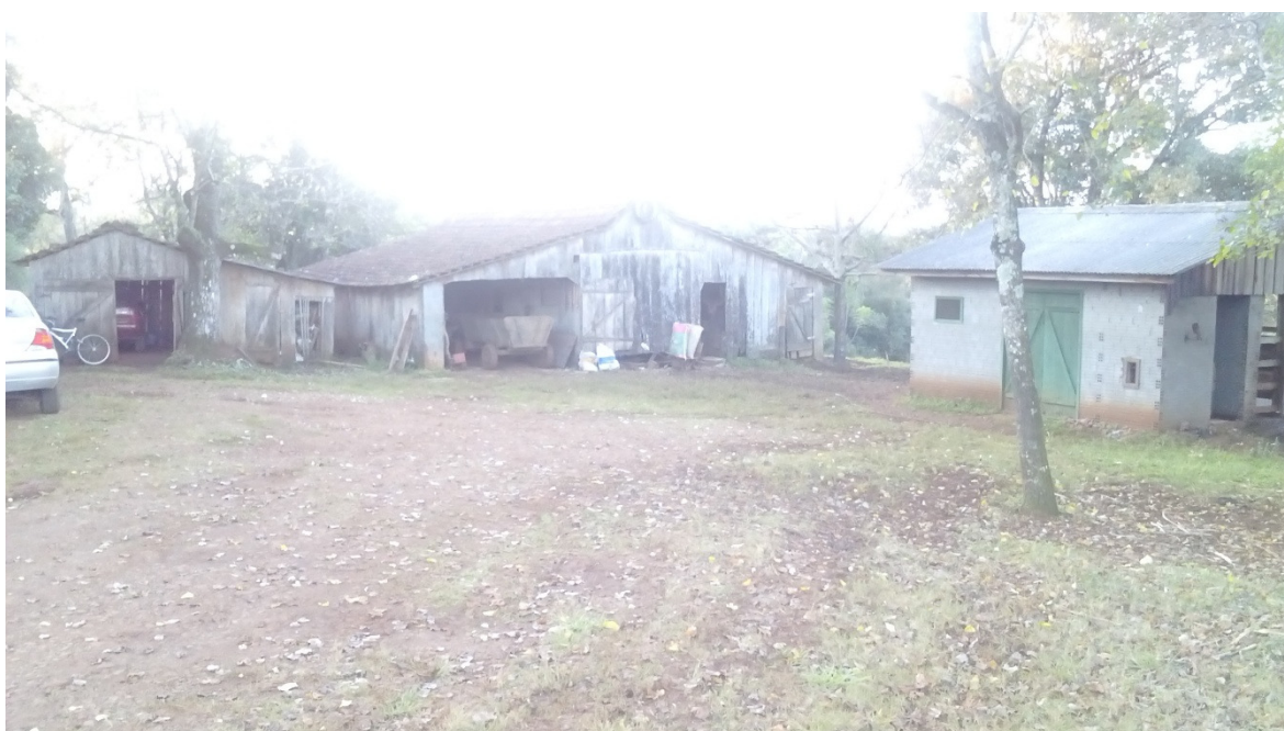
Figura 7 - Vista das instalações da propriedade, galpão a ser reformado e sala para resfriador
