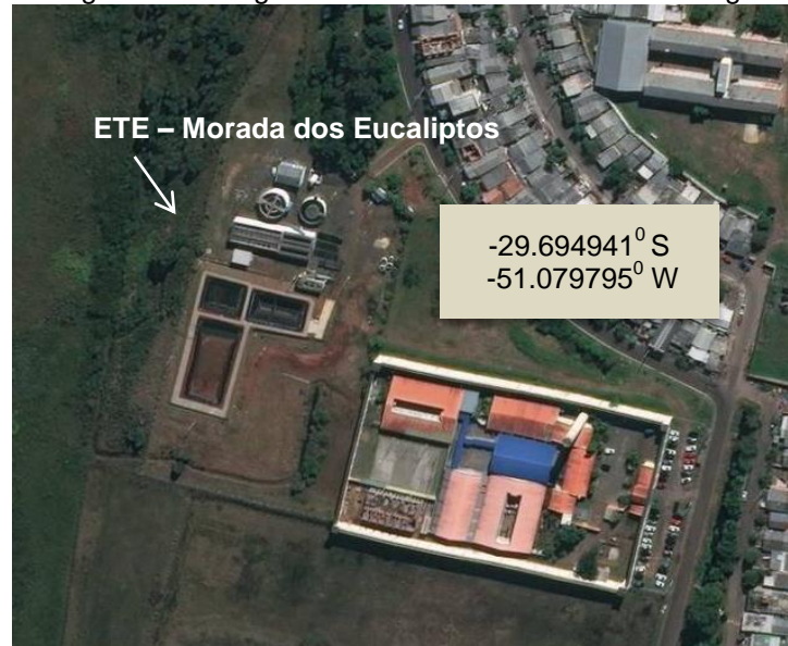
Figura 13 - Imagem aérea da ETE de Novo Hamburgo
