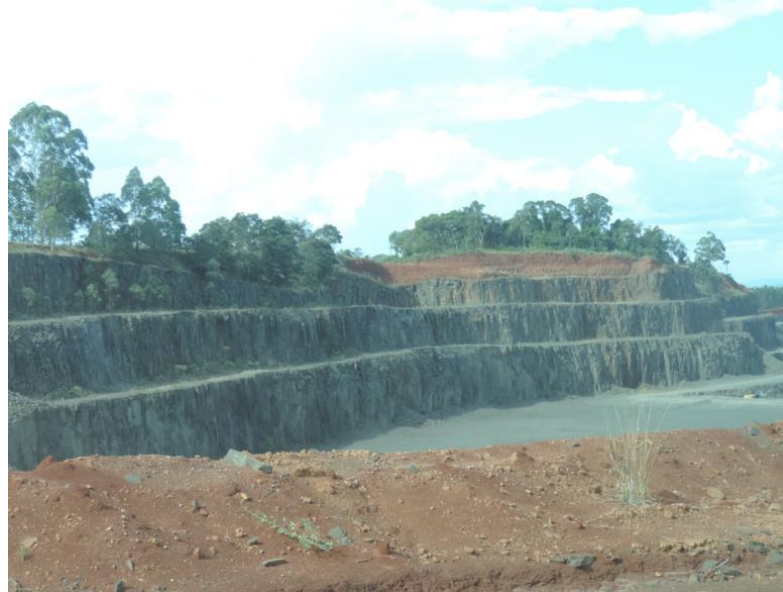
Figura 3 - Sucessão de bermas e taludes e a espessura da camada de solo de cobertura
