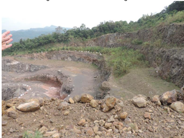
Figura 4 - Bermas sendo revegetadas
