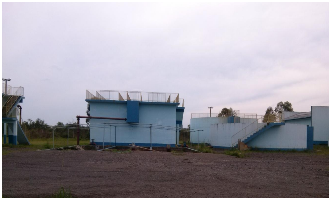
Figura 21 - Visão Geral da ETE Morada dos Eucaliptos.
