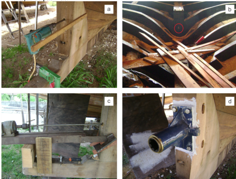
Vista externa (a) e interna (b) da confecção do furo piloto (nota-se a broca atravessando o patilhão na área circulado em vermelho); alargamento (c); e fixação da cabeça de túnel (d).
