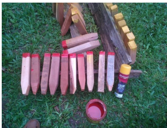
Figura 12 - Fabricação dos piquetes para topografia
