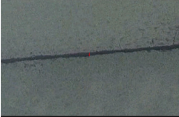
Canal de drenagem no banhado Grande em 2003 com 3,87 metros de largura
