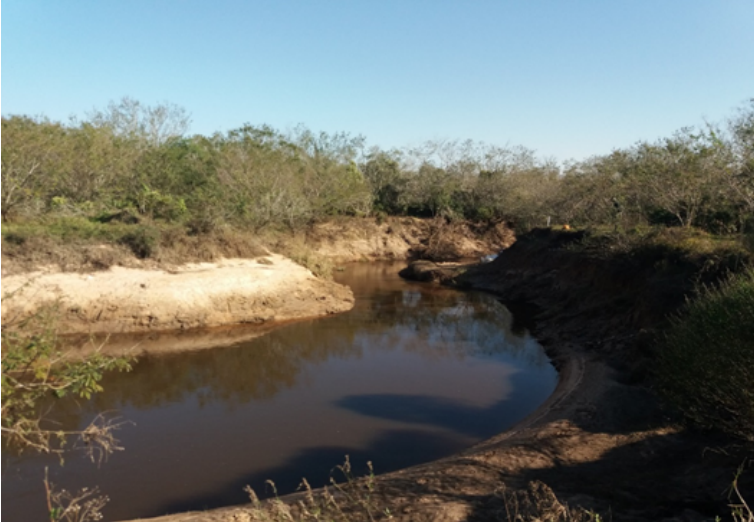
Figura 10. Trecho de maior alargamento da voçoroca na área do Banhado Grande com solo exposto na vertente. Ao lado direito da imagem está a margem erosiva da voçoroca, já ao lado esquerdo, encontra-se a margem deposicional dos sedimentos. Assim o processo de erosão se dá na margem côncava e de deposição na margem convexa. Foto: Etchelar, 28 de junho de 2017.
