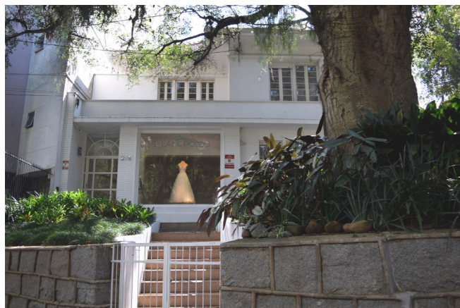
Casa a ser demolida na Dinarte Ribeiro
