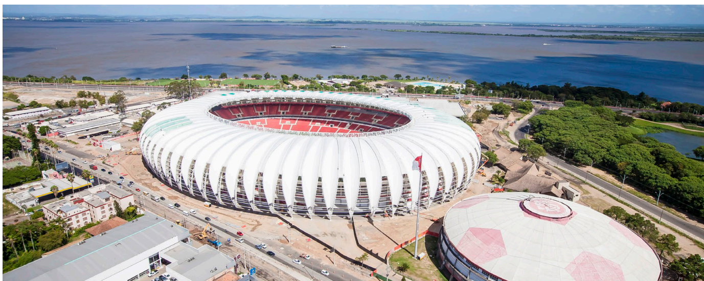
Vista aérea do complexo Beira-Rio durante as obras de 2014. Foto: Gabriel Heusi / Fonte: http://fotospublicas.com
