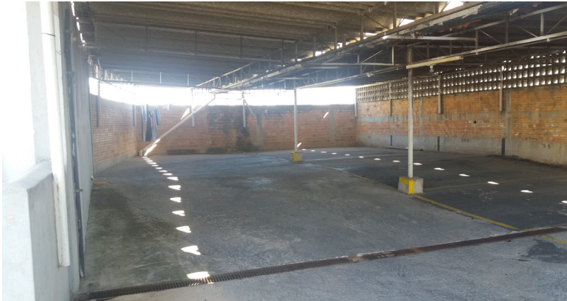
Vagas localizadas na cobertura, desnível entre patamares = 35cm
