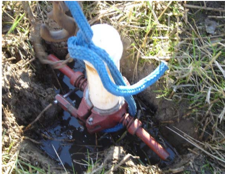
Figura 6.1.2 – Término do processo de percussão manual visando a penetração de cano de PVC.
