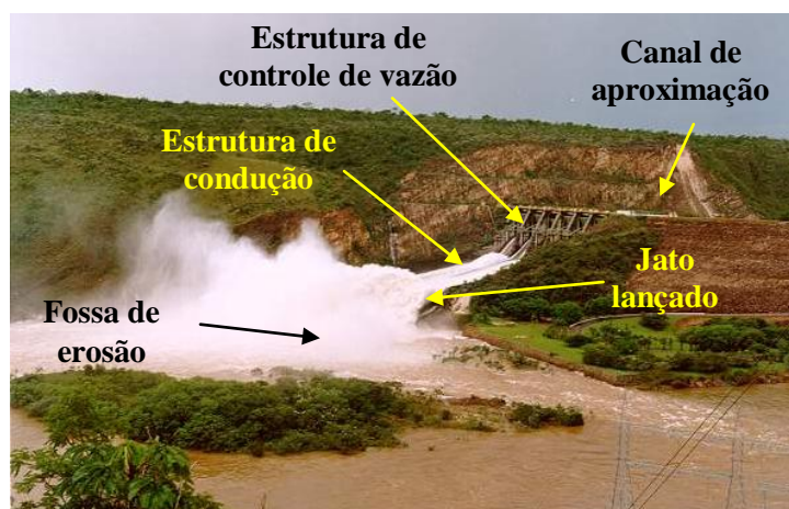
Figura 2 – Identificação de elementos básicos de um sistema dissipador – usina hidrelétrica de Luiz Carlos Barreto de Carvalho – Furnas Fonte: Adhemir Baptista Liporone, no site: < http://mapio.net/pic/p-5211088/ >.
