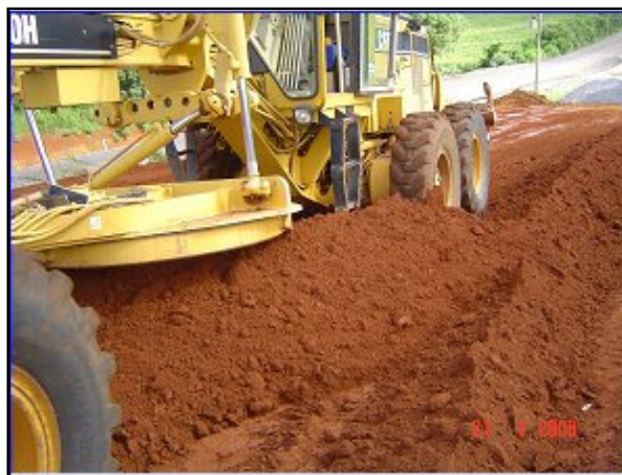
Figura 32: disposição do solo argiloso em leiras. Fonte: Registro fotográfico do autor
