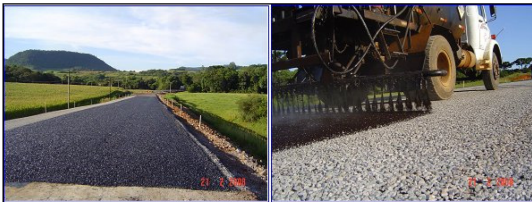
Figura 52: aplicação de RR-2C(segunda camada)
