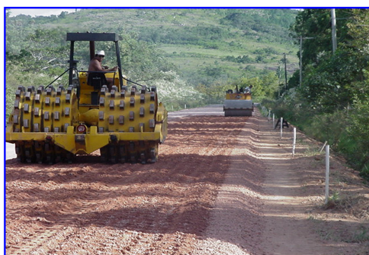
Figura 5: execução do solo-agregado Fonte : CPR/DAER
