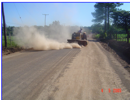
Figura 14 : varrição da base de solo-agregado para proceder a imprimação Fonte: Couto (2006, acervo do autor).
