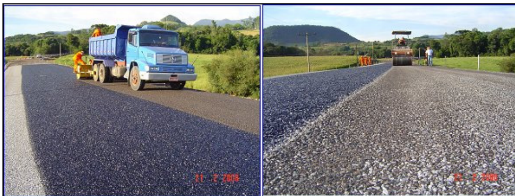
Figura 54: distribuição de agregado 3/8"
