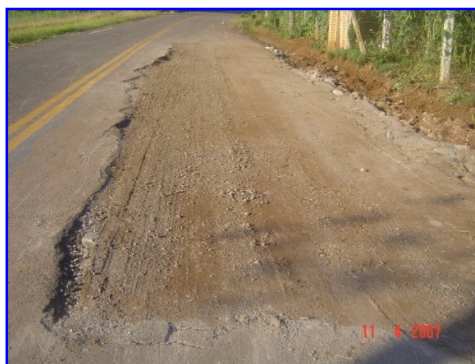
Figura 15 : Problemas de deformações plásticas (RSC 129, Km 23+100 em 2007) Fonte: Couto (2007, acervo do autor).
