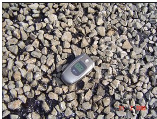
Figura 51: aspecto final da primeira camada de ligante e agregado.
