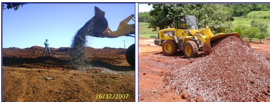
Figura 33: disposição em camadas do solo-agregado Figura 34: mistura do solo-agregado Fonte: Registro fotográfico do autor
