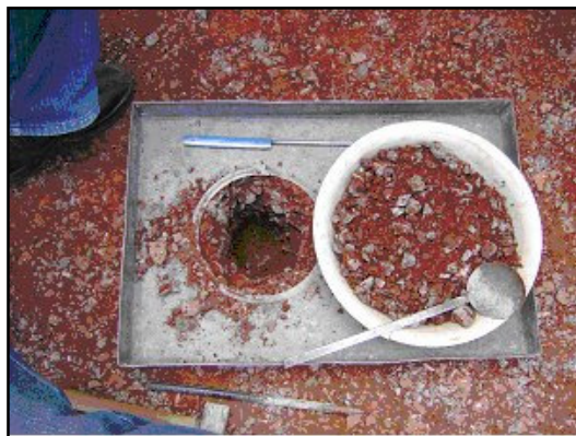
Figura 44: Realização de ensaio de cone de areia. Fonte: Registro fotográfico do autor
