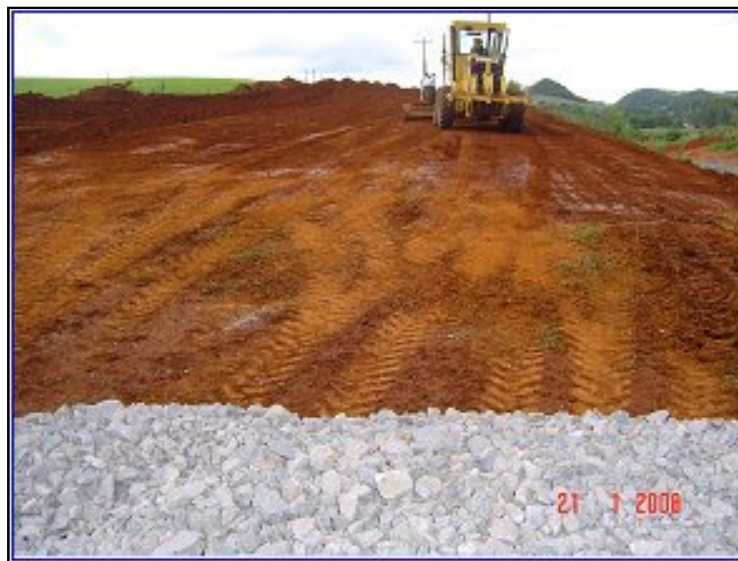
Figura 31: situação do agregado pétreo na jazida, prestes a ser misturado à argila. Fonte: Registro fotográfico do autor
