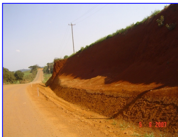
Figura 9: jazida de argila laterítica ao lado da rodovia em construção – RS 129/Km 23 Fonte: Couto (2007, acervo do autor).
