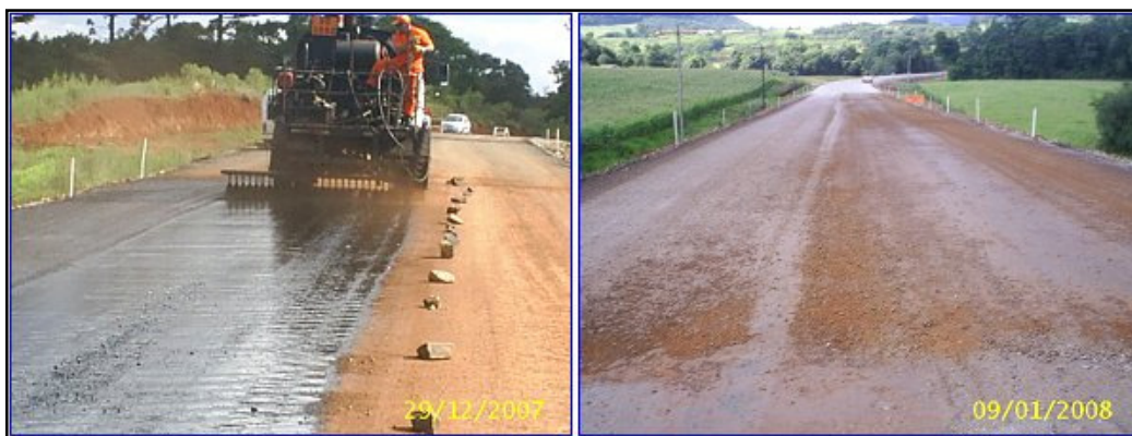
Figura 45: aplicação da imprimação
