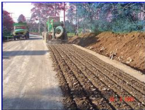
Figura 13: escarificação para incorporação de material na camada Fonte: Couto (2006, acervo do autor).
