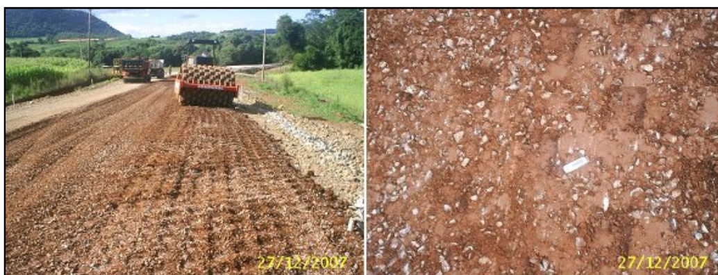
Figura 39: Compactação com rolo corrugado
