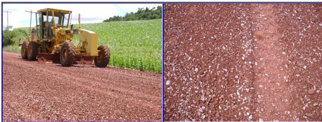
Figura 37: Espalhamento com motoniveladora
