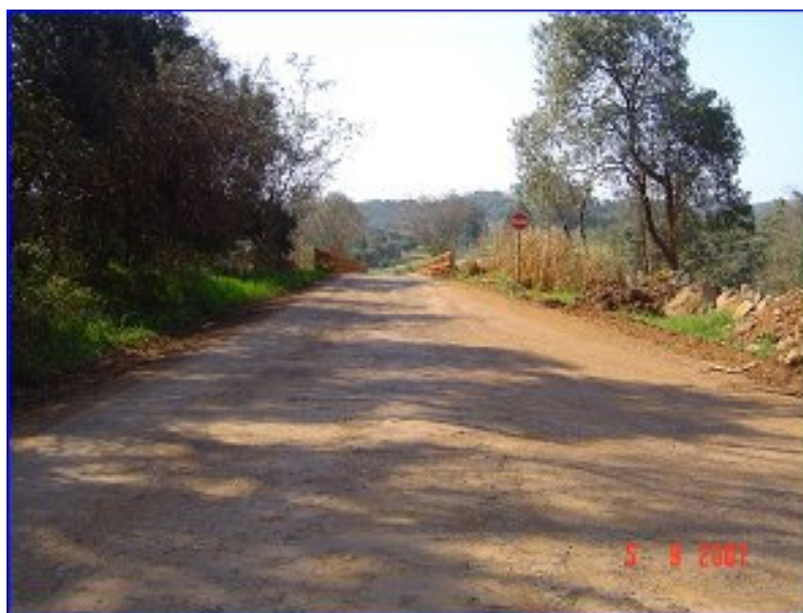
Figura 26: segmento da RSC129 Km 23+300 lado Casca. Fonte: Registro fotográfico do autor
