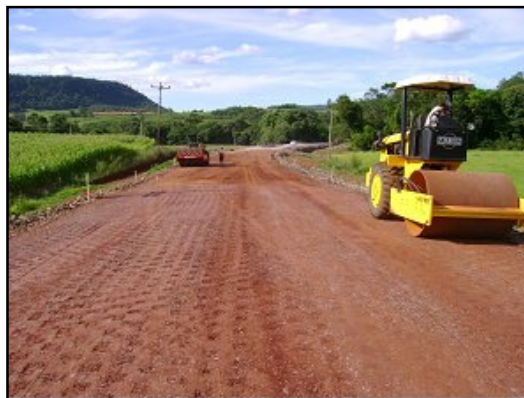
Figura 41: Compactação com rolo liso Fonte: Registro fotográfico do autor
