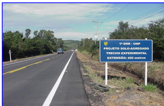
figura 6: aspecto geral do trecho experimental Fonte : CPR/DAER
