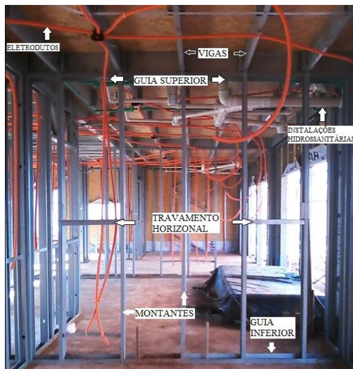
Figura 2.4 – Nomenclatura dos componentes de um painel estrutural (FRAGA, 2016)
