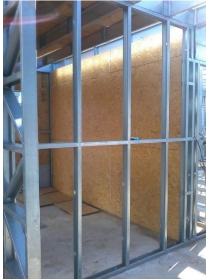
Figura 2.3 – Painel de perfis de aço formados a frio, à frente, e placa OSB, na lateral esquerda da parede ao fundo (FRAGA, 2016)
