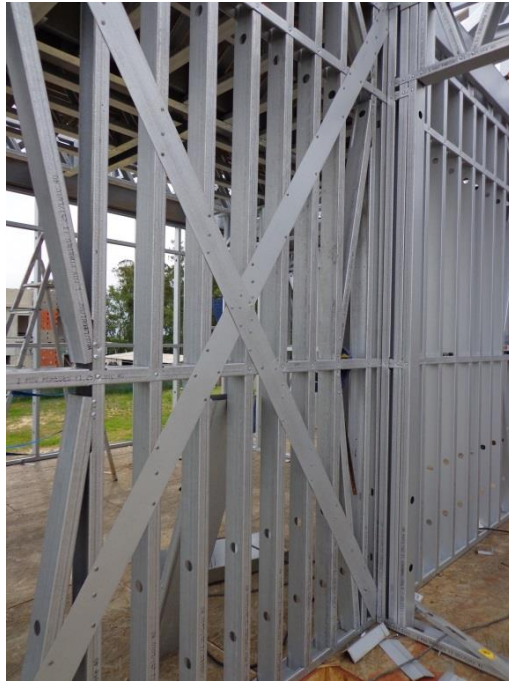
Figura 2.6 – Pannel estrutural em steel frame
