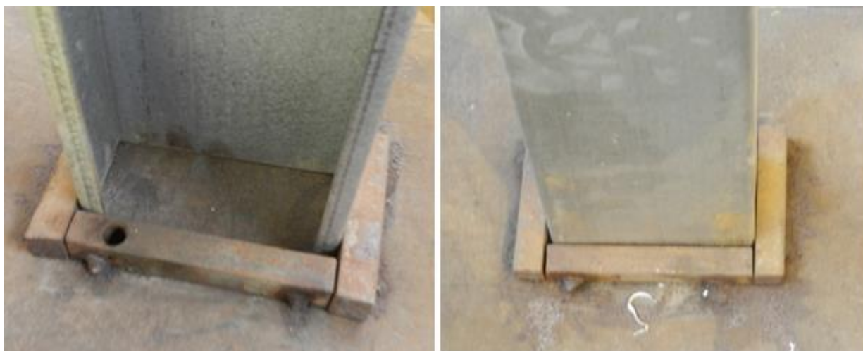
Figura 5.3– Sistema de fixação inferior dos perfis
