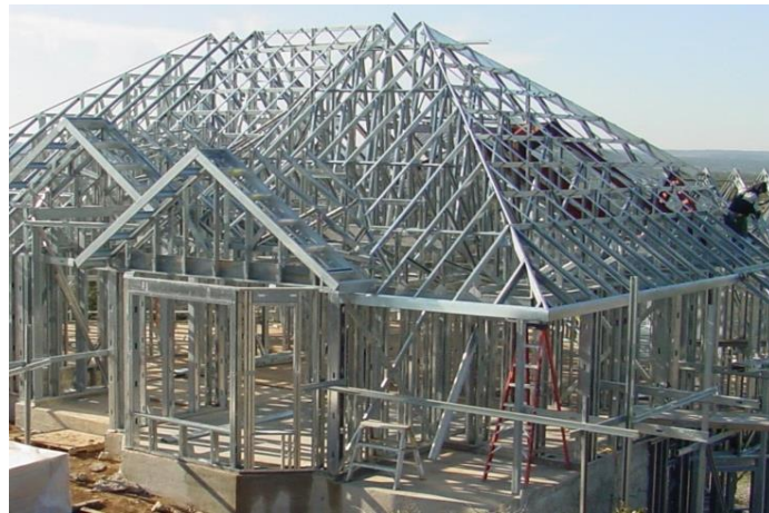
Figura 1.1 – Esqueleto estrutural em steel frame (GRAN, 2016)
