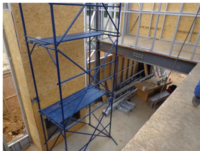
Figura 1.2 – Obra limpa e organizada
