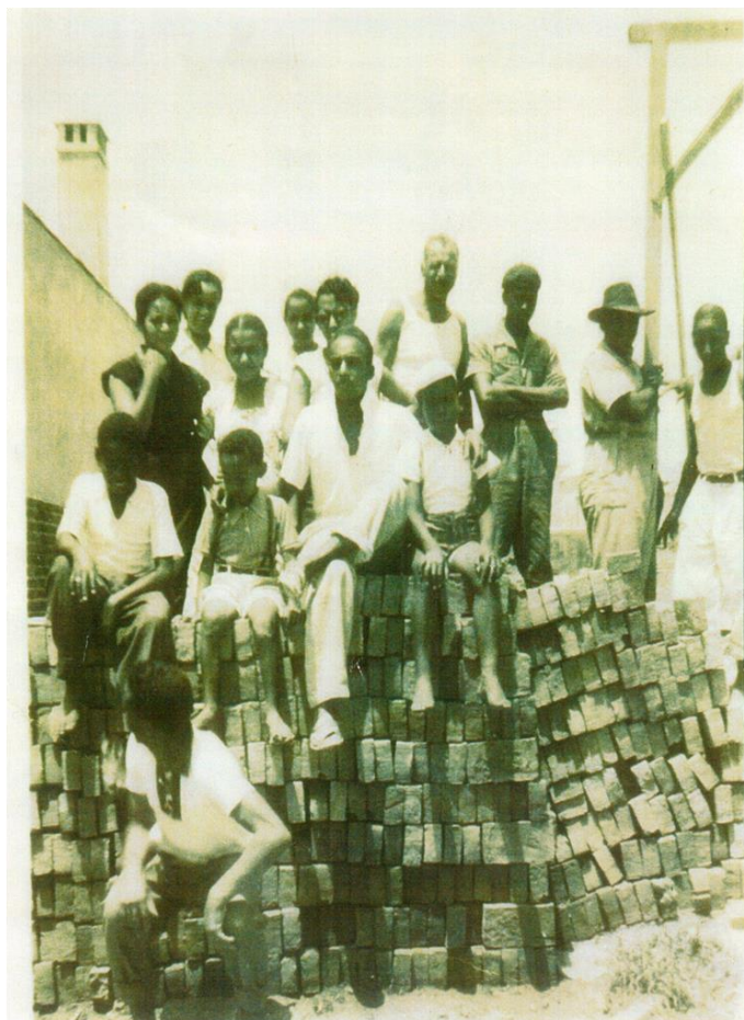
Figura 18: Associados do clube trabalhando na construção da sede
