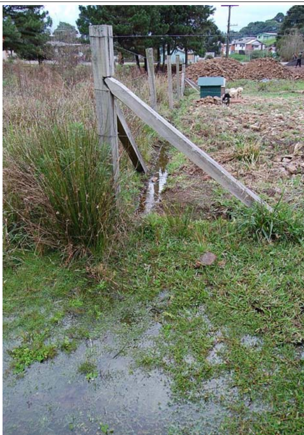
Figura 40: Terreno alagadiço soerguido com material extraído da pedreira. Data: 07/06/2008
