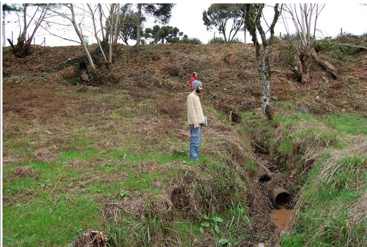
Figura 17: Esgoto pluvial na área da nascente (Ponto 1). Data: 07/06/2008
