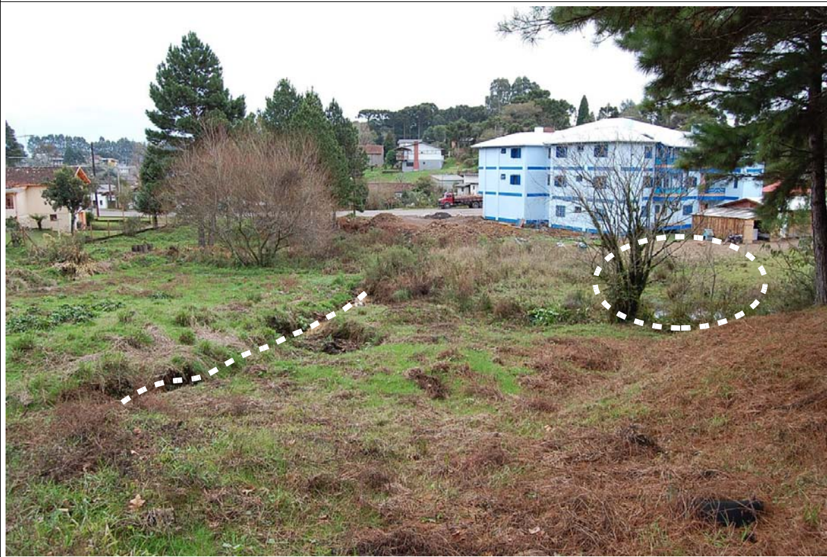
Figura 18: A linha pontilhada representa o esgoto pluvial e a elipse, a área do olho d'água (Ponto 1). Data: 07/06/2008
