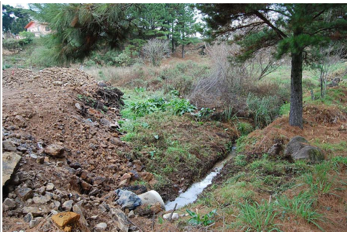
Figura 41: Canalização do esgoto pluvial misturado à água da nascente. Data: 07/06/2008
