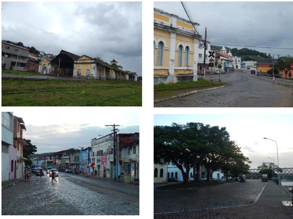
Foto 14 – São Félix. Da esquerda para a direita: estação ferroviária, via até a Ponte D. Pedro II e orla do rio.
