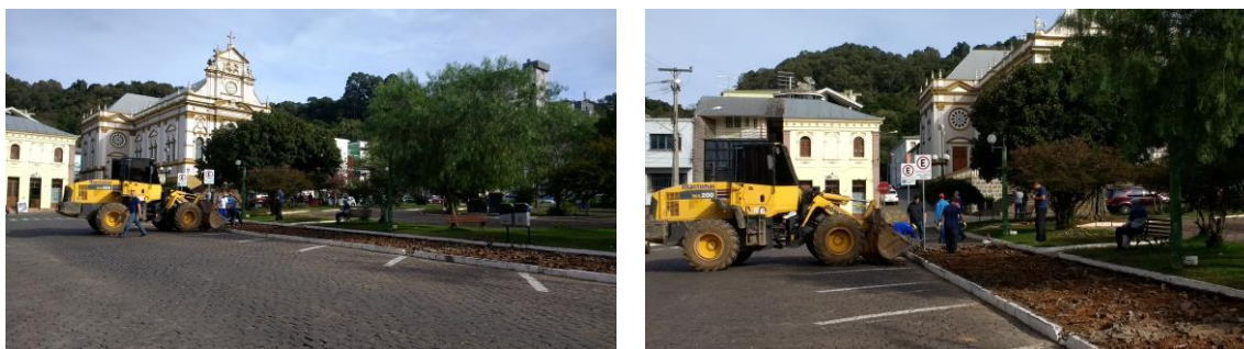
Foto 15 – Antônio Prado. Início das obras na Praça Garibaldi.
