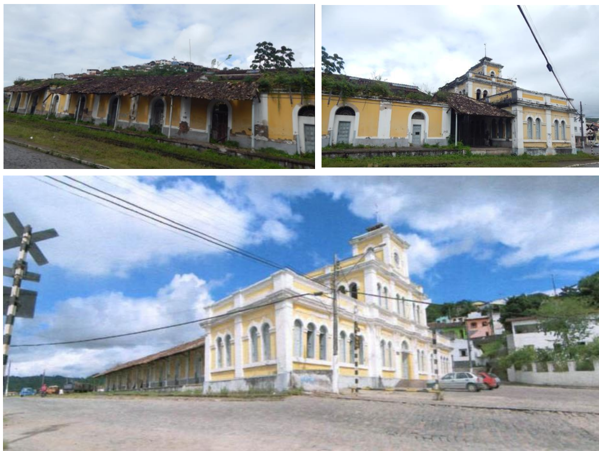
Foto 20 – São Félix. Estação Ferroviária em 2017 e 2008.
