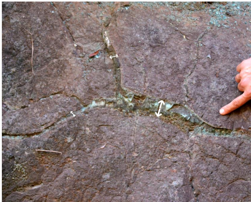
Figura 20: fraturas em "Y", com setas indicando movimento trativo de abertura das fraturas, quando estas se desenvolvem.
