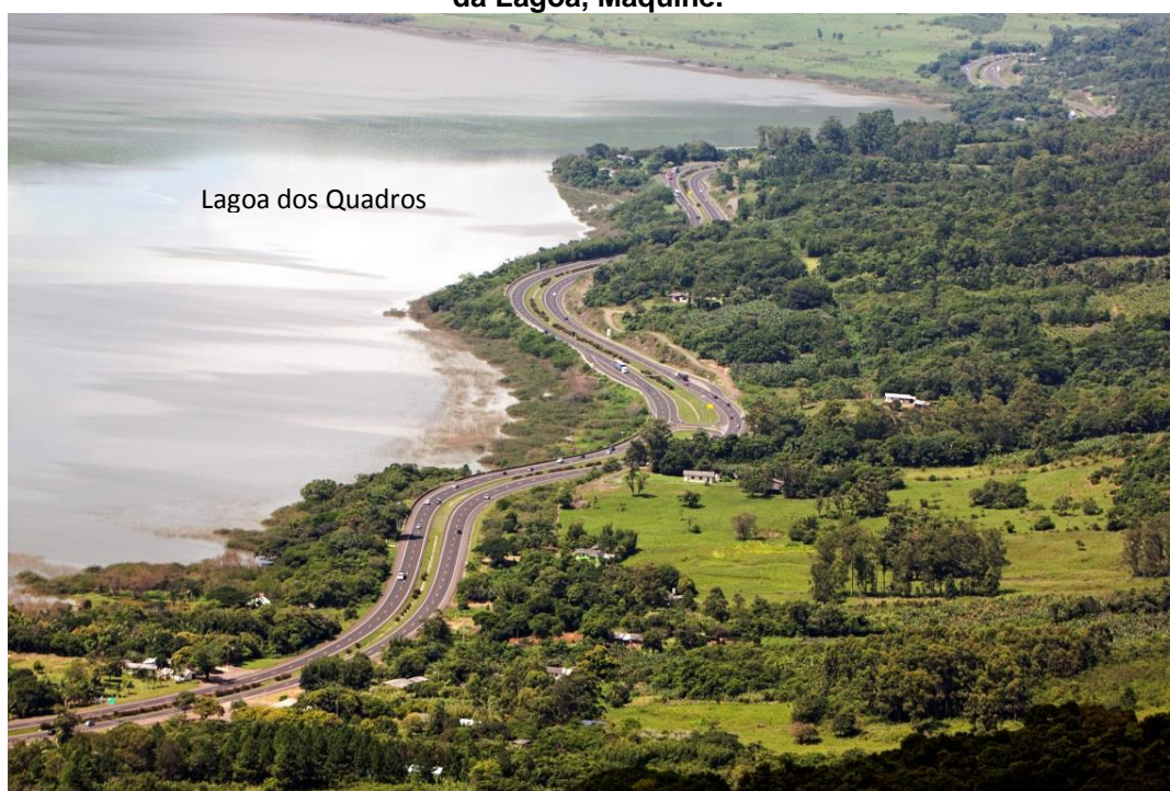
Fig 56: BR 101, em área de preservação permanente da lagoa dos Quadros. Costa da Lagoa, Maquiné.
