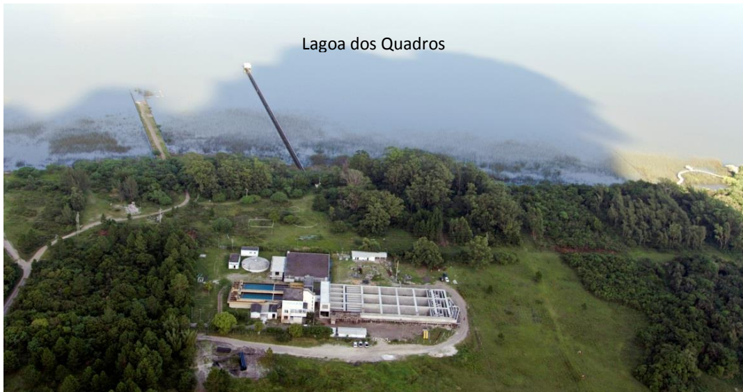
Fig 57: captação de água da Companhia Riograndense de Saneamento (CORSAN) para os municípios de Capão da Canoa e Xangri-lá.
