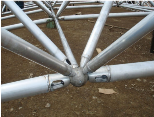
Figura 3 : Nó da estrutura (foto do autor)
